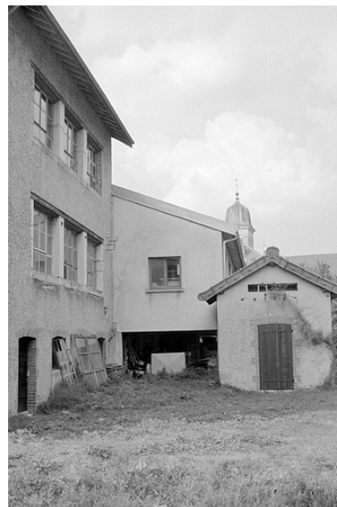
Façade postérieure et transformateur. Phot. Laurent Poupard IVR43_19913901113Z
