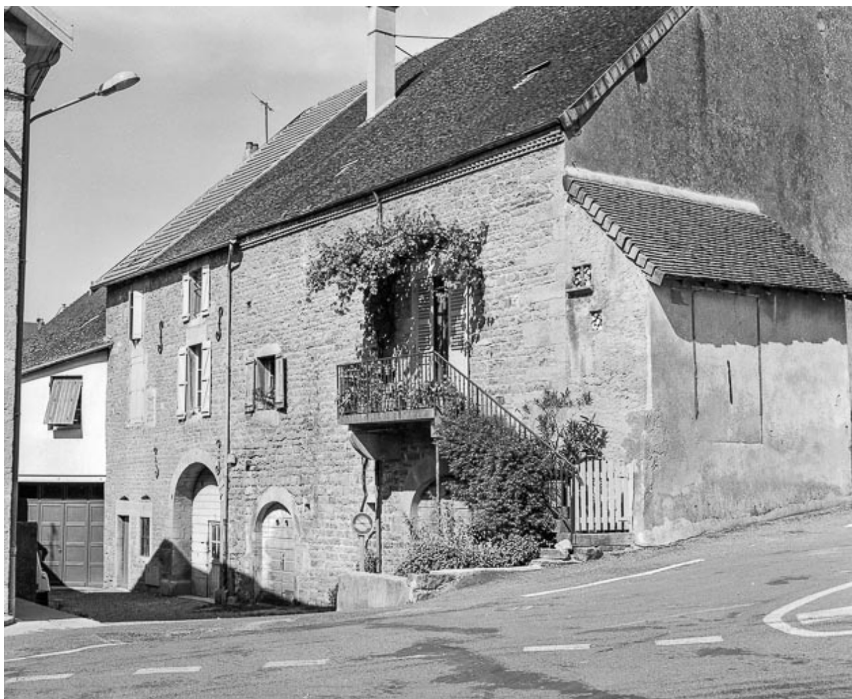
Maison de vigneron située 2 rue de la Batavarde.
