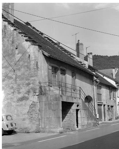
Maison de vigneron située 21 rue de Villard. Phot. Dominique Dominguez IVR43_19803900182X
