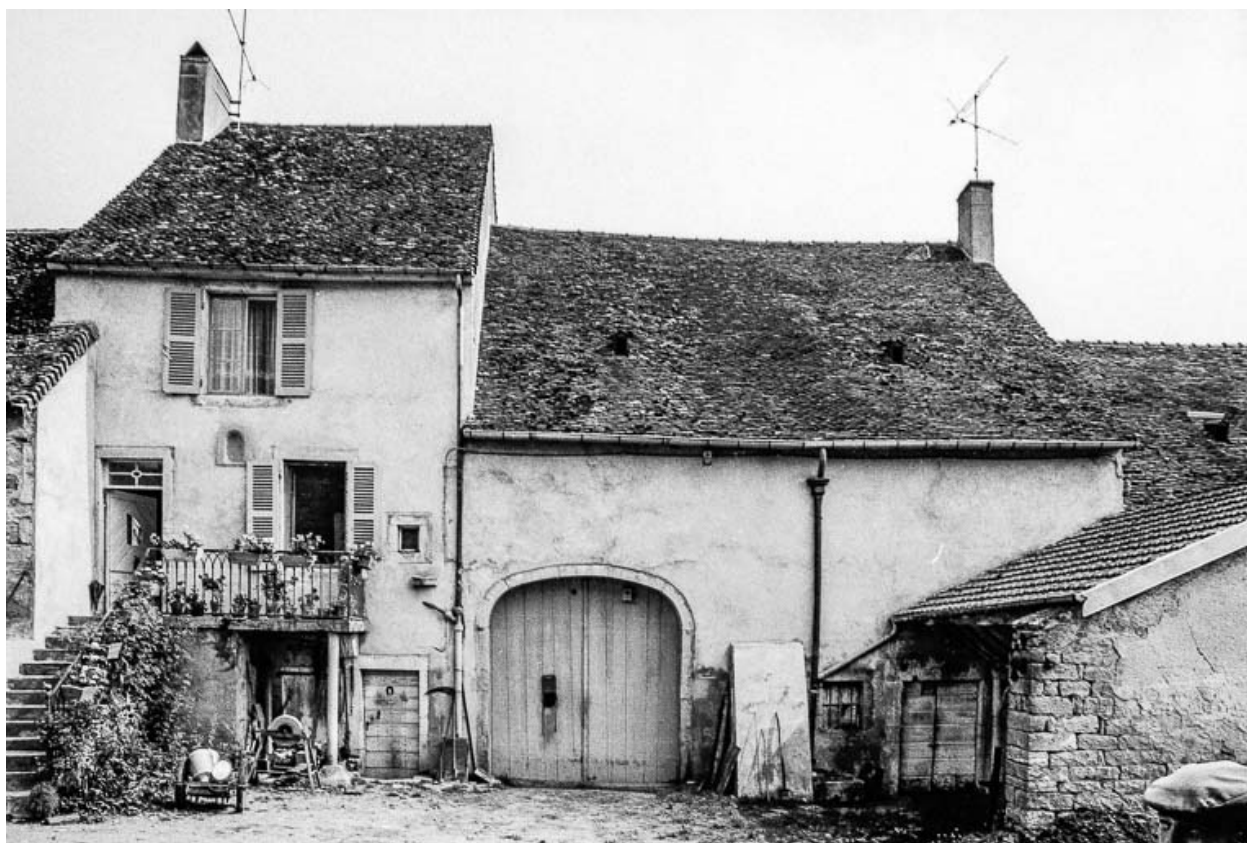
Ferme cadastrée 1964 AC 90 (droite) : façade antérieure.
