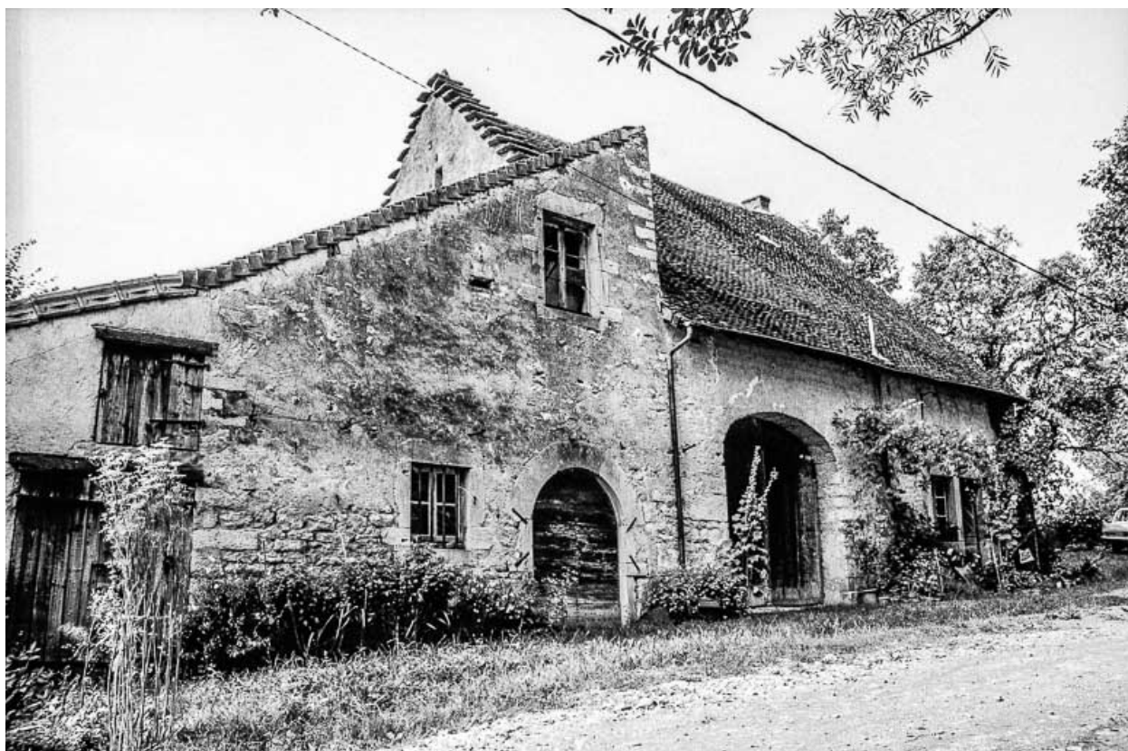
Ferme cadastrée 1964 AC 48 : vue d'ensemble.
