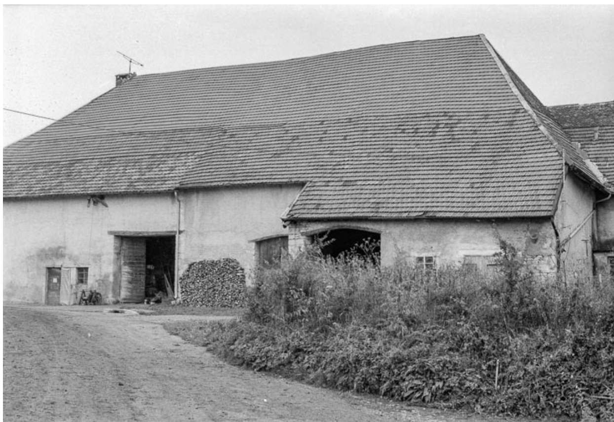
Ferme cadastrée 1939 F 2-3 : façade latérale droite.
