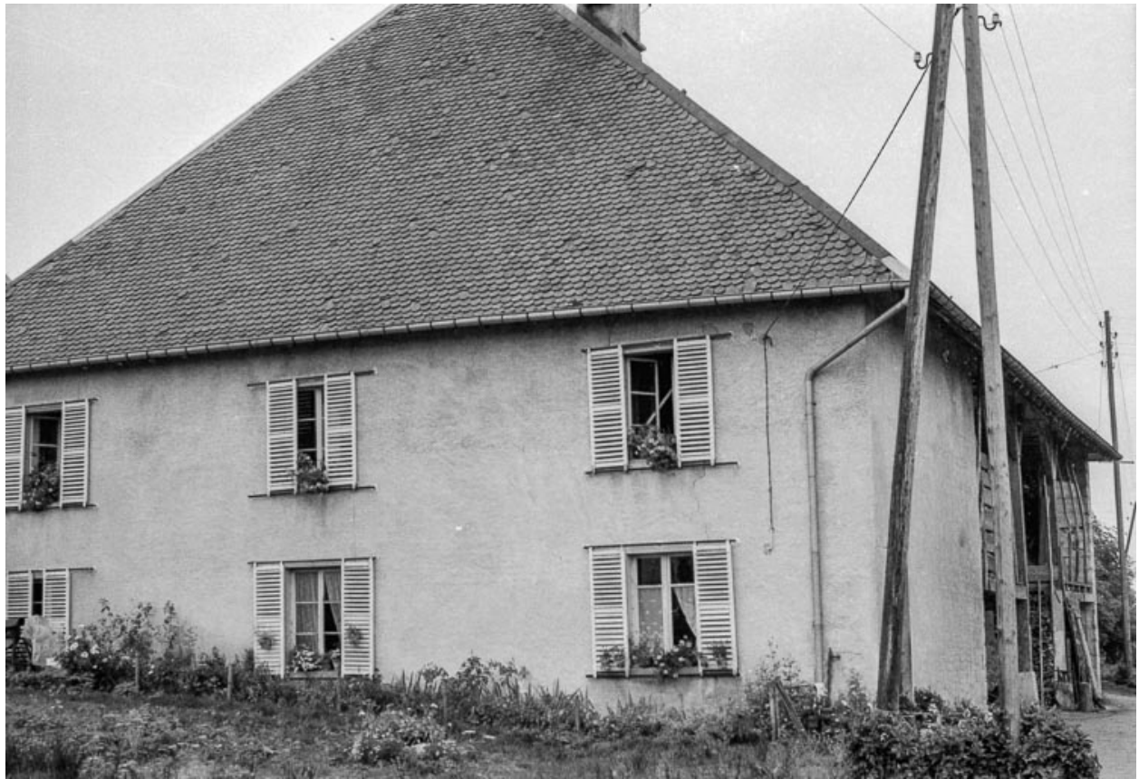
Ferme cadastrée 1939 B 192 : façade latérale gauche.
