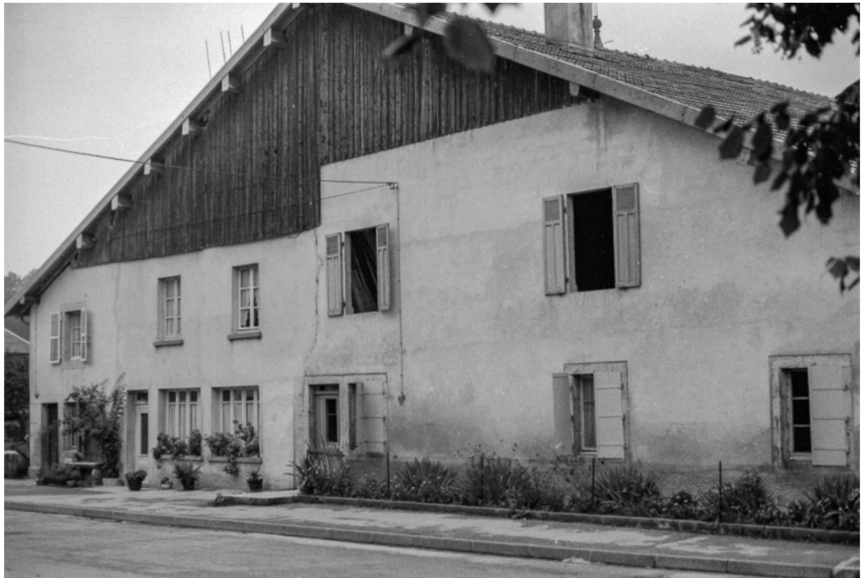
Ferme cadastrée 1939 F 183-184 : façade antérieure.
