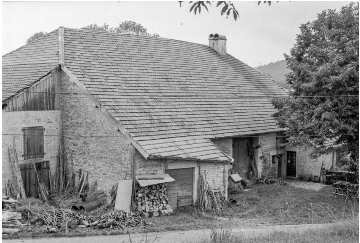
Ferme cadastrée 1939 F 28 : vue d'ensemble.
