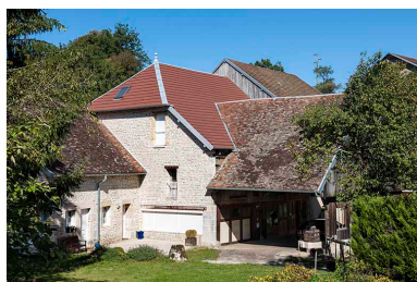
Ateliers de la scierie et du moulin. Phot. Jérôme Mongreville IVR43_20152501841NUC4A
