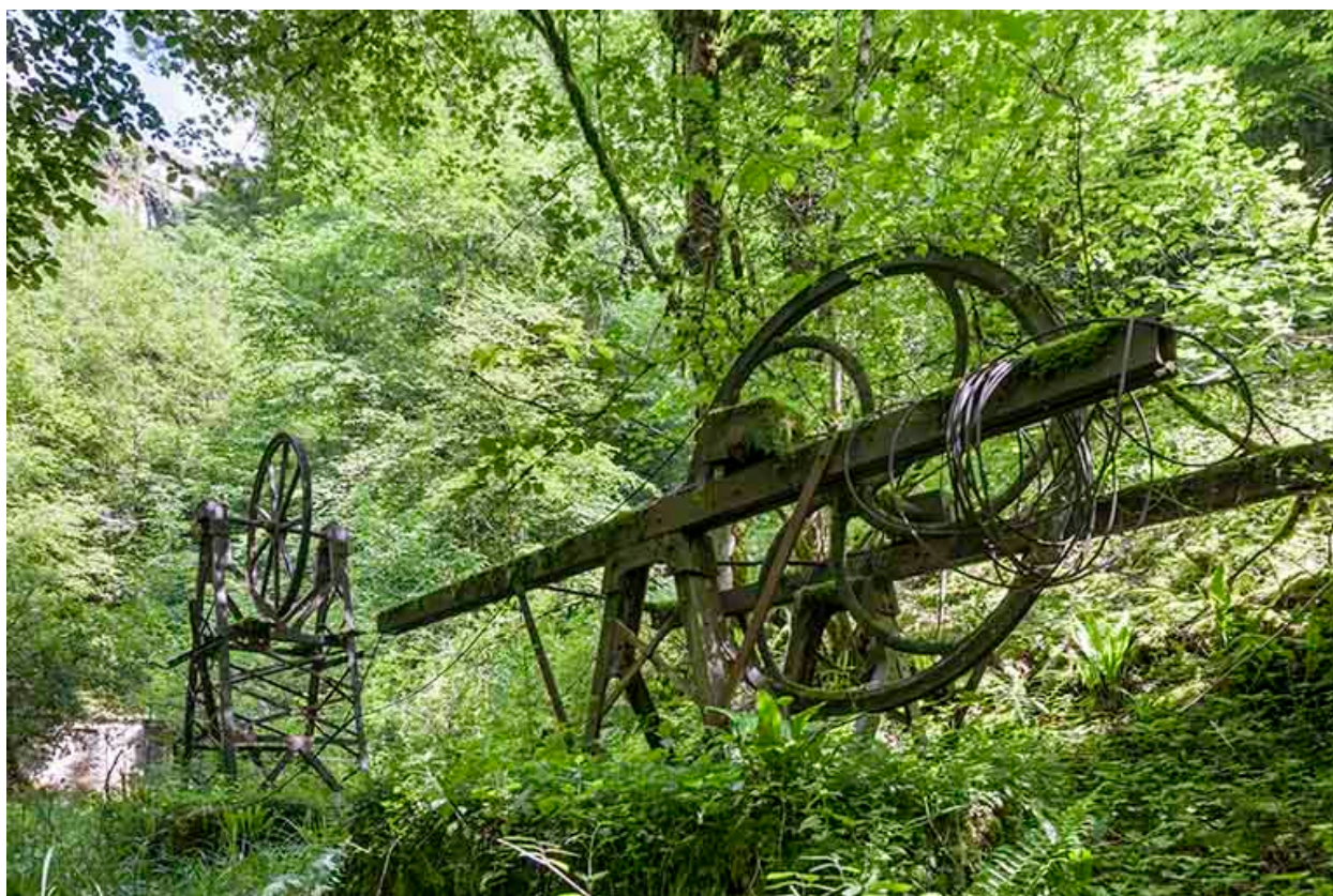
Supports métalliques de la transmission par câble.
