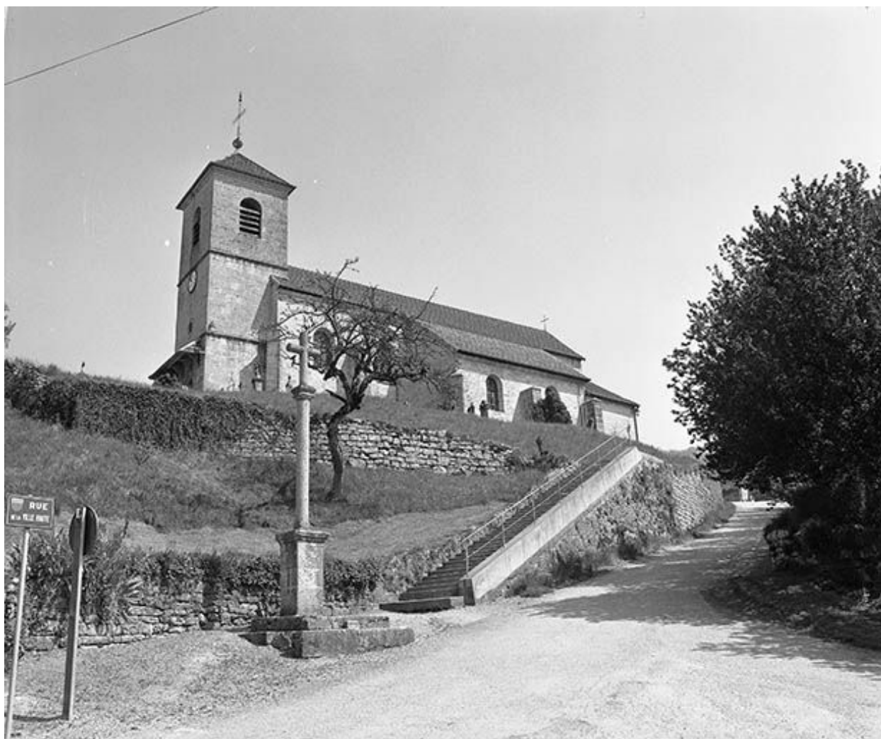
Façade antérieure et face latérale droite.
