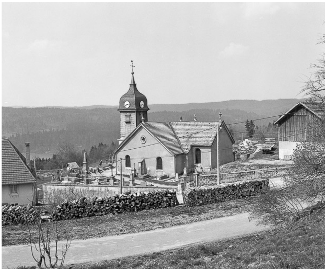
Vue d'ensemble éloignée.
