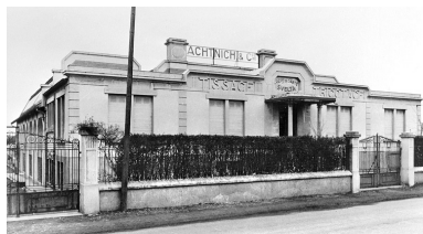
Façade de l'usine. Phot. Yves Sancey IVR43_20009000895X
