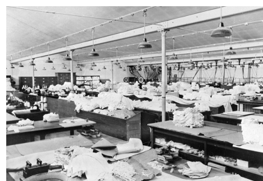
Etage supérieur : atelier de finition (?). Phot. Yves Sancey IVR43_20009000911X
