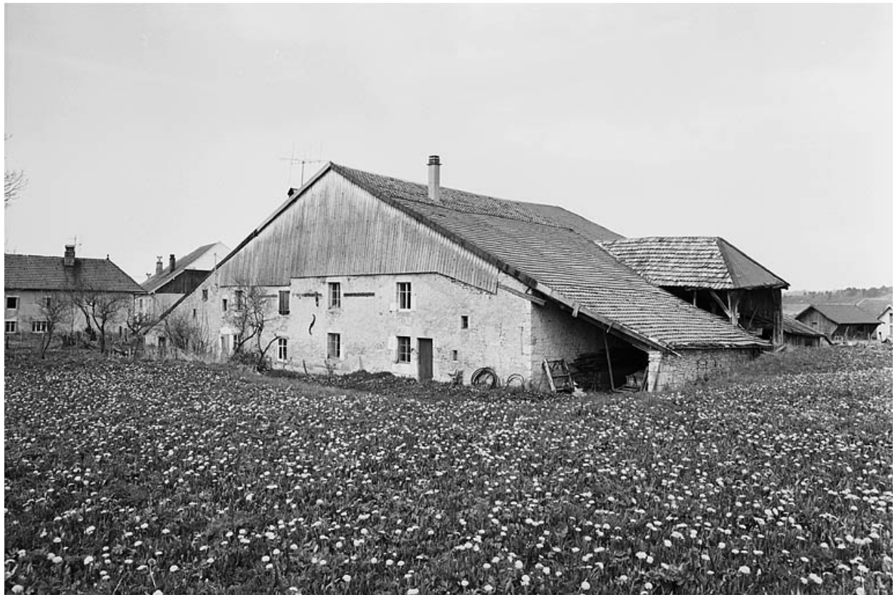
Extérieur : pignon de l'habitation et goutterot postérieur.
