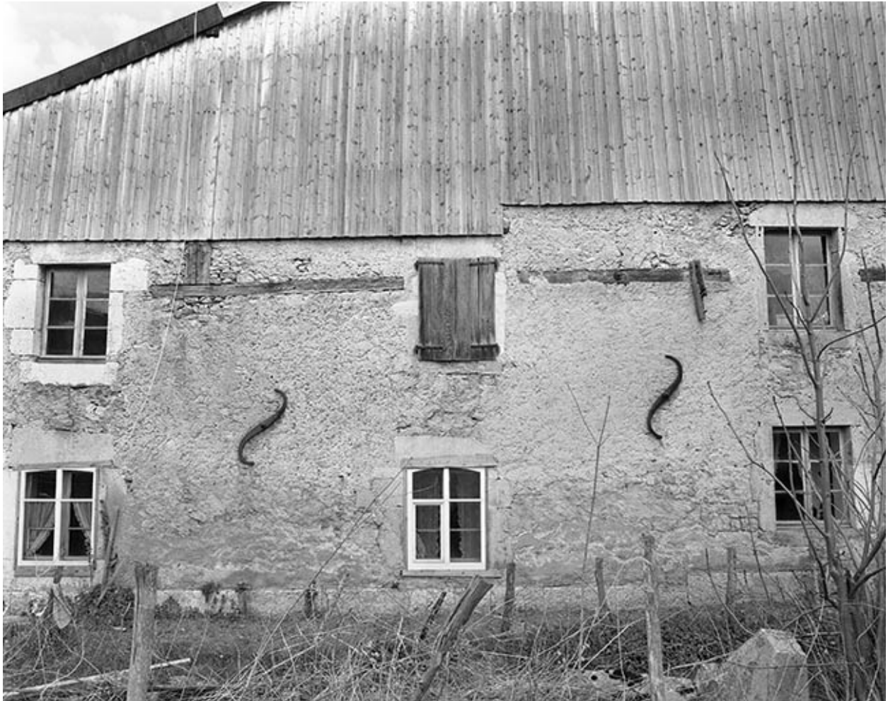
Détail du pignon d'habitation.
