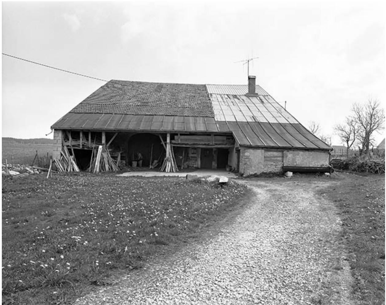
Extérieur : gouttereau antérieur.
