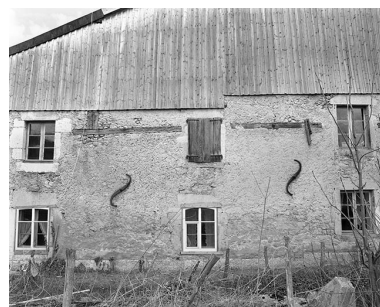
Détail du pignon d'habitation. Phot. Dominique Dominguez IVR43_19792500280X
