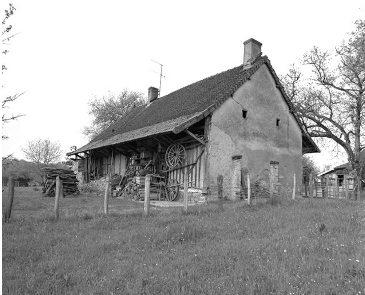
Façades postérieure et latérale gauche.
