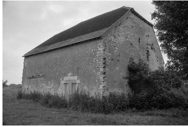
Façade postérieure. Phot. Bernard Lardière IVR43_19817000391Z
