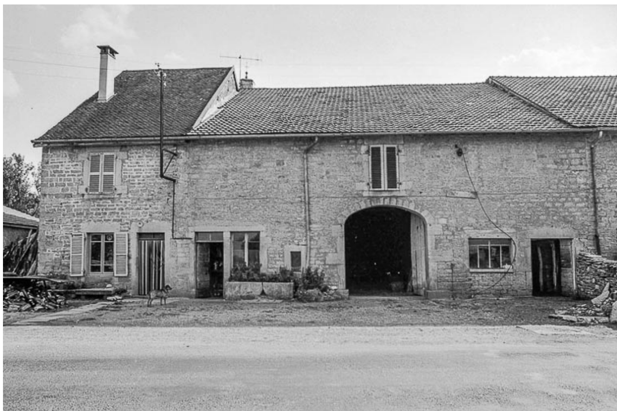
Ferme cadastrée A3 195 : façade antérieure.
