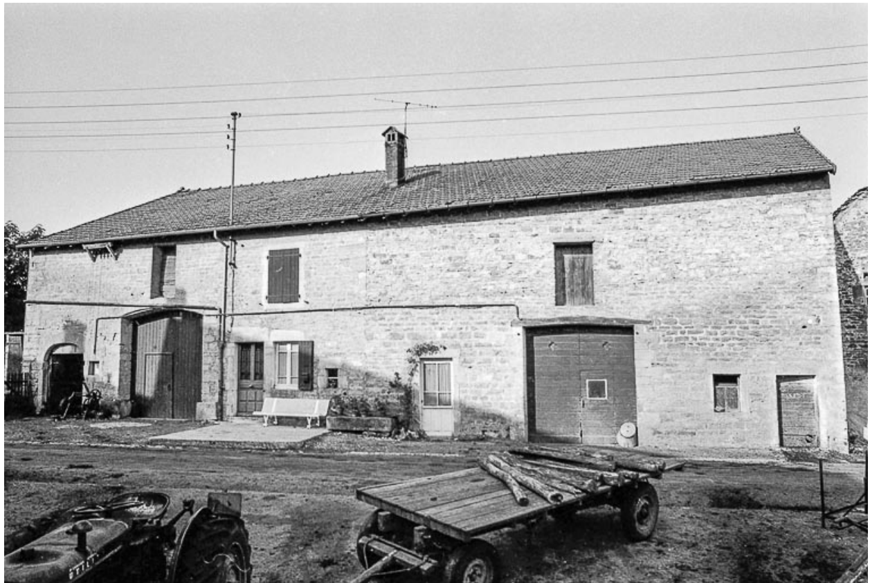
Ferme cadastrée A3 204 : façade antérieure.
