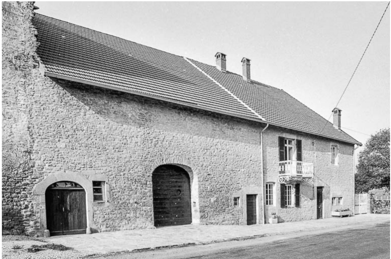
Ferme cadastrée A3 218 : façade antérieure.
