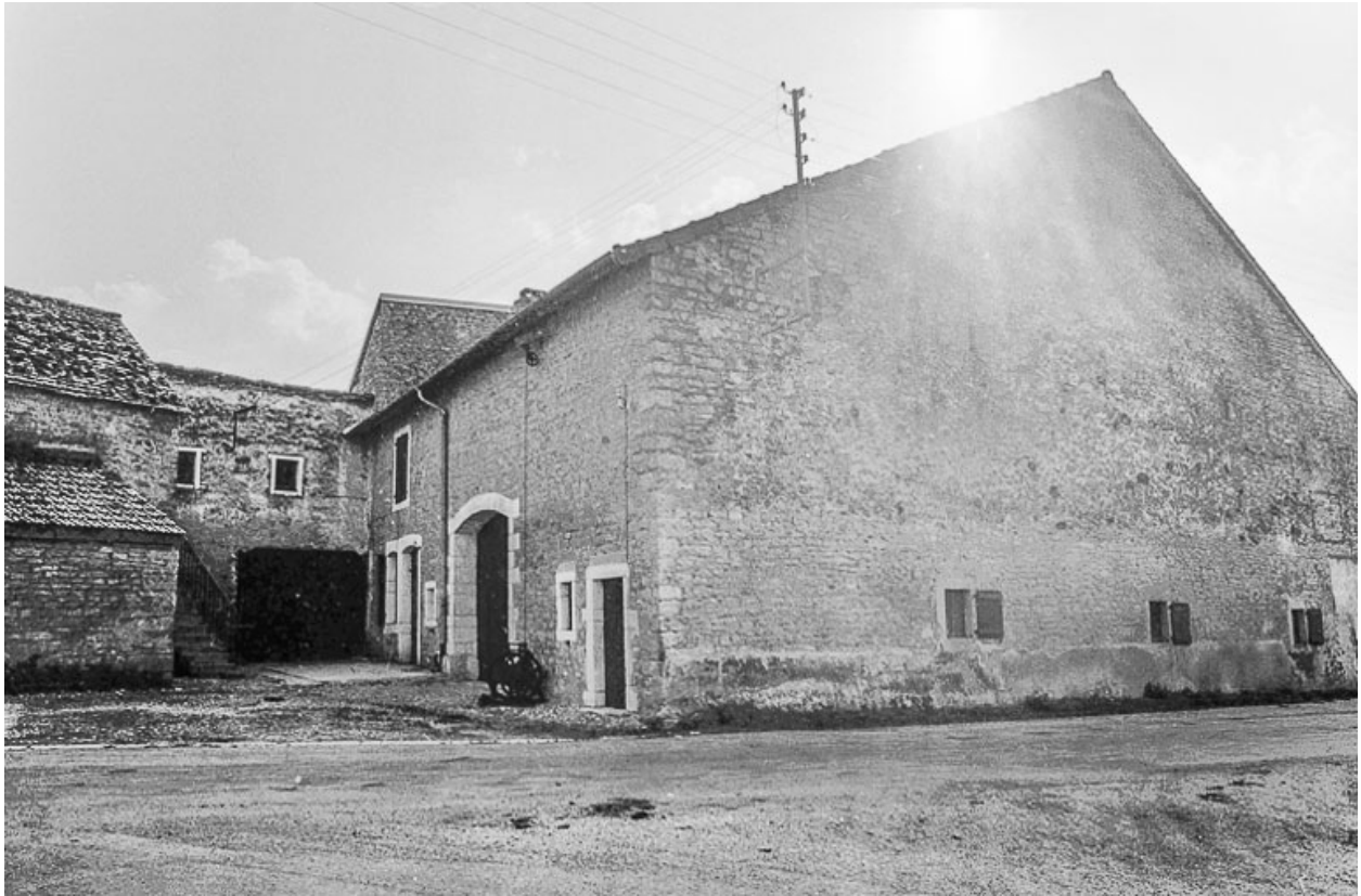
Ferme cadastrée A3 206 : façade antérieure.
