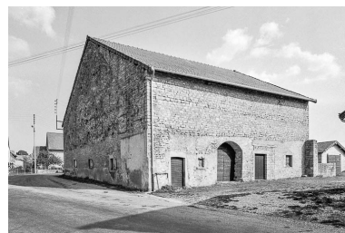
Ferme cadastrée A3 206 : façade postérieure. Phot. Bernard Pontefract IVR43_19763900377Z
