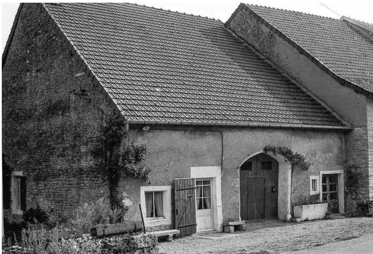
Ferme cadastrée A3 170 : façade antérieure.
