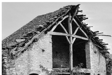
Ferme cadastrée B3 256 : toiture. Phot. Bernard Pontefract IVR43_19763900375Z
