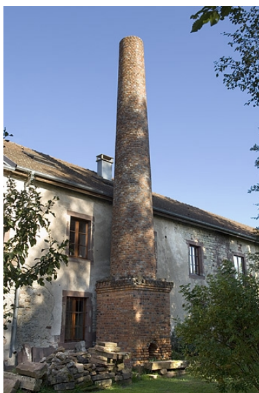
Cheminée. Phot. Jérôme Mongreville IVR43_20067000761NUCA
