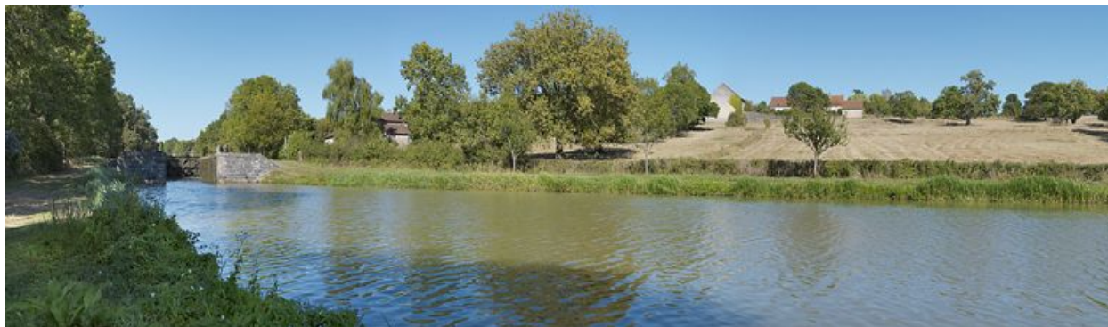
Vue générale du site d'écluse, d'aval.
