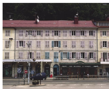
Vue d'ensemble des n° 131 et 133. Phot. Jérôme Mongreville IVR43_20003900384XA
