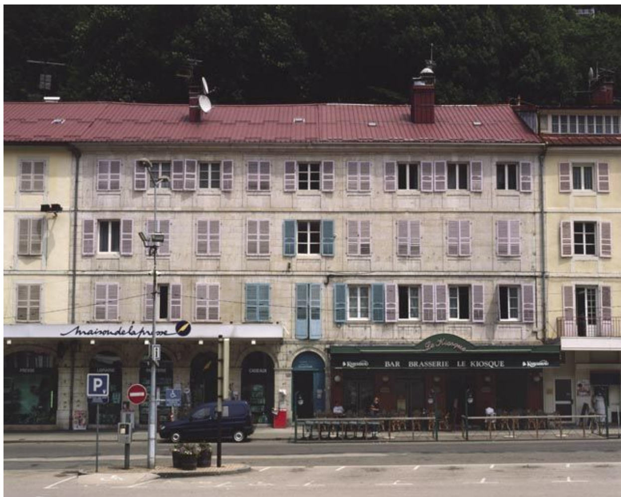
Vue d'ensemble des n° 131 et 133.
