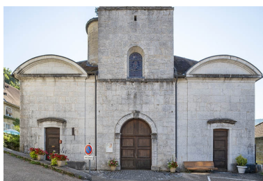
Façade antérieure en 2021. Phot. Jérôme Mongreville IVR43_20212500133NUC4A
