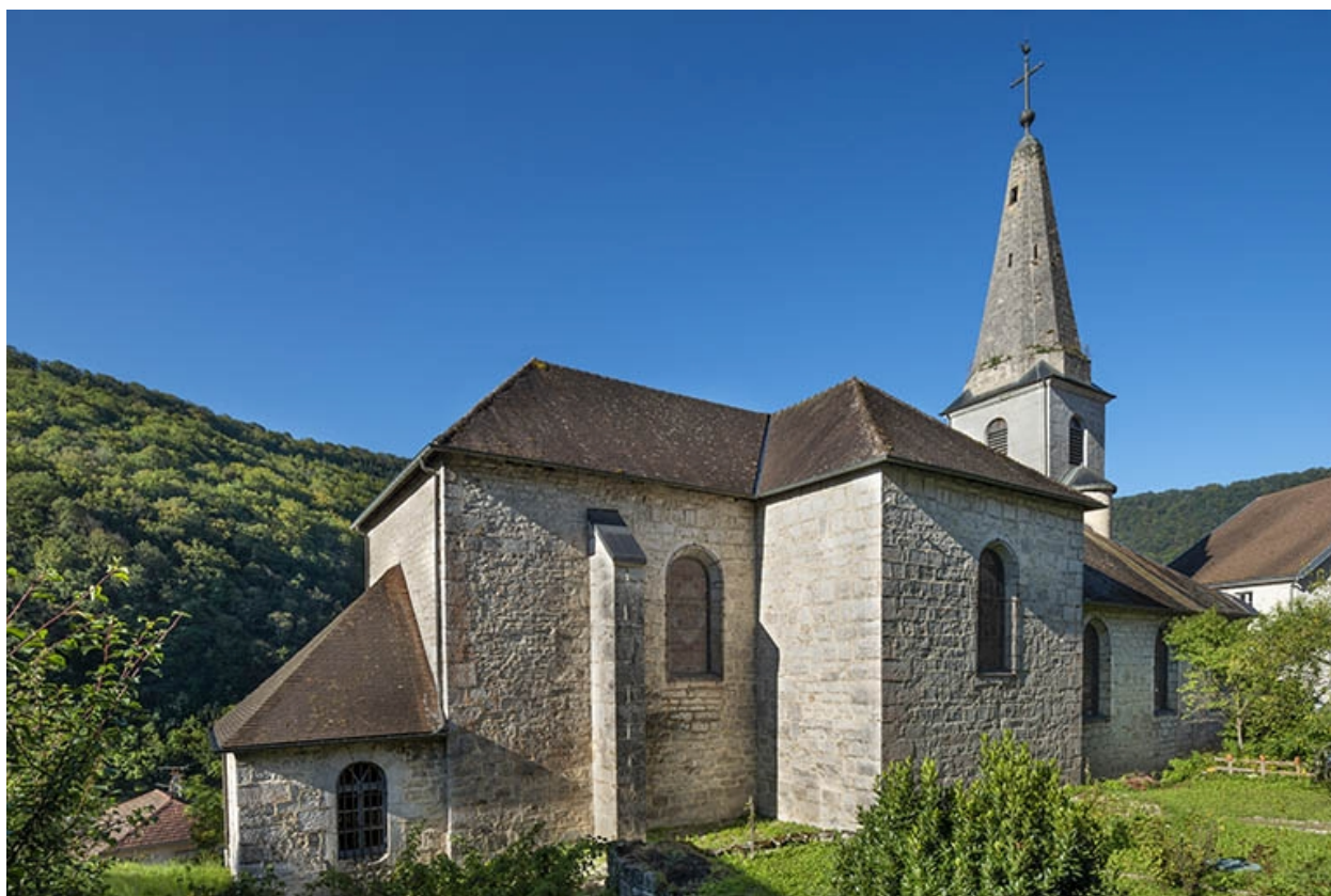
Façade latérale gauche en 2021.
