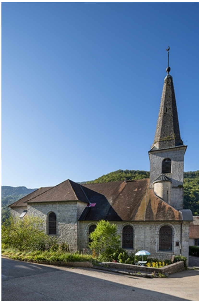
Façade latérale gauche en 2021.
