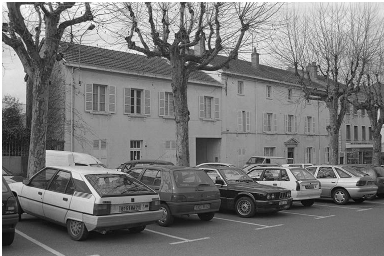
Façade antérieure du presbytère, vue de l'est.
