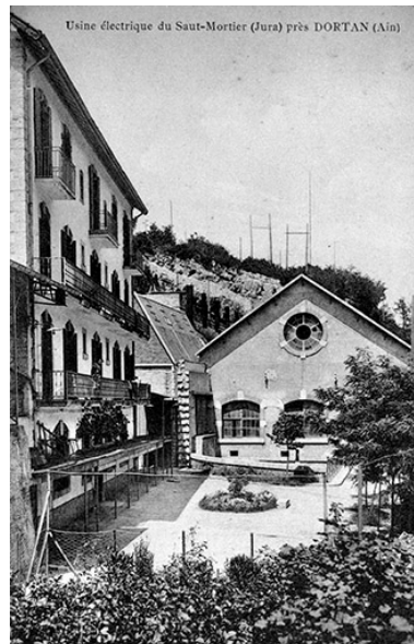
Usine électrique du Saut- Mortier (Jura) près DORTAN (Ain). Phot. Yves Sancey IVR43_19883900432X
