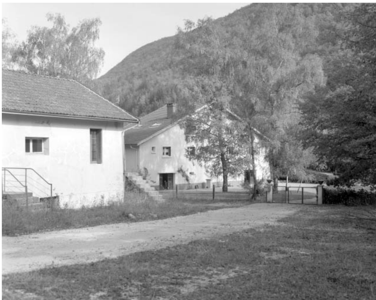
Logement de contremaître.
