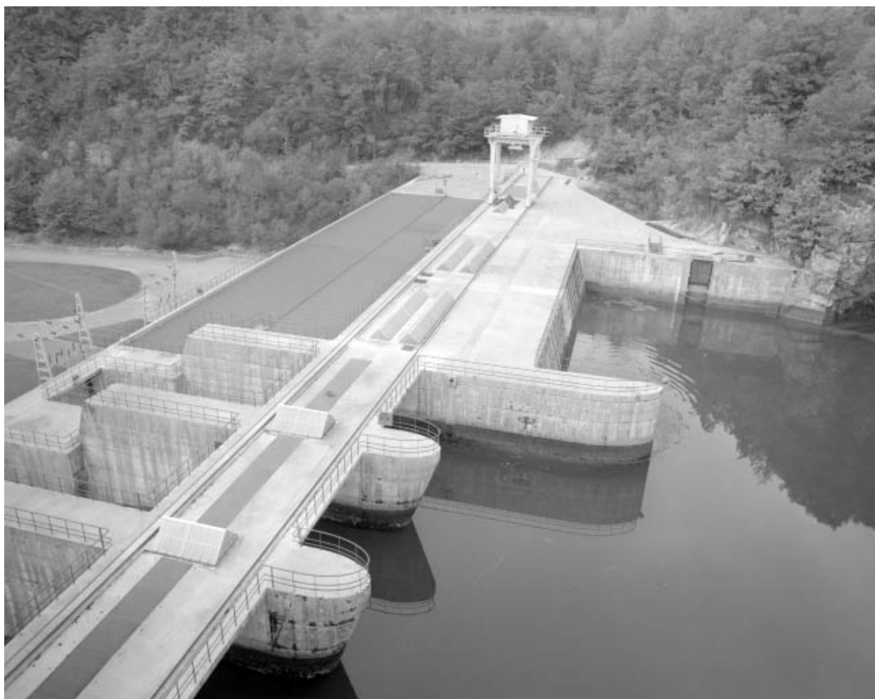
Evacuateur de crue et toiture de l'usine.
