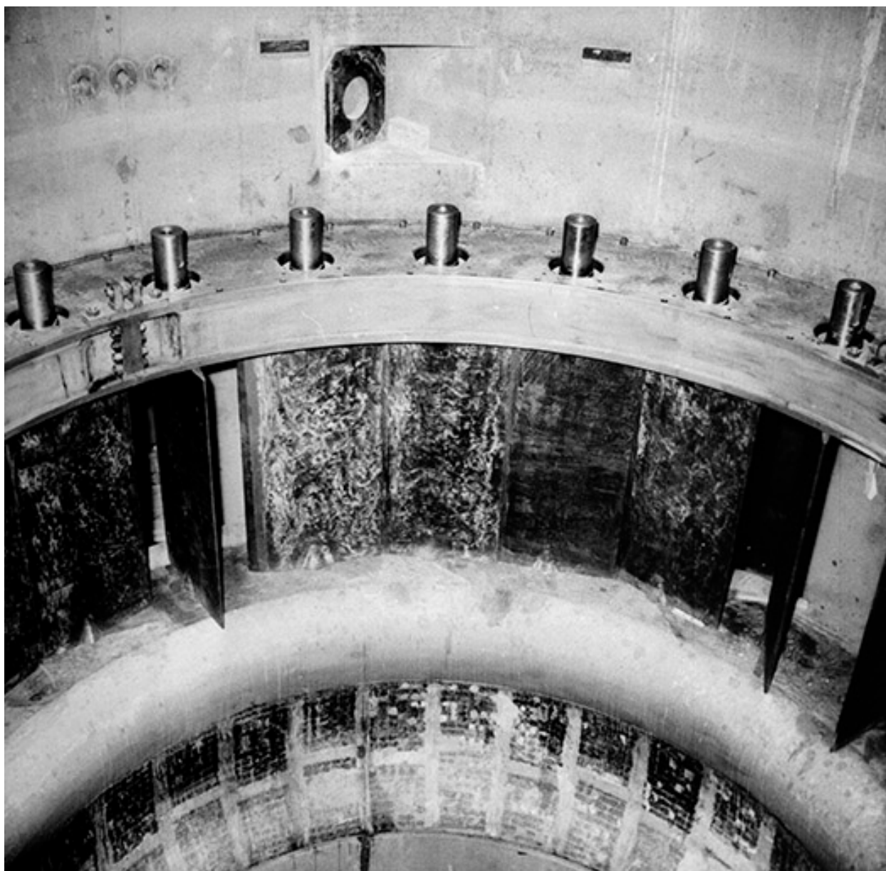
Turbine G.1 : distributeur en cours de montage.
