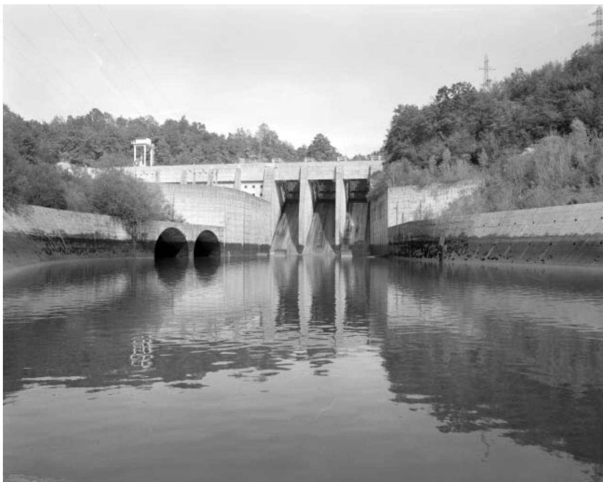
Evacuateur et bassin d'amortissement.
