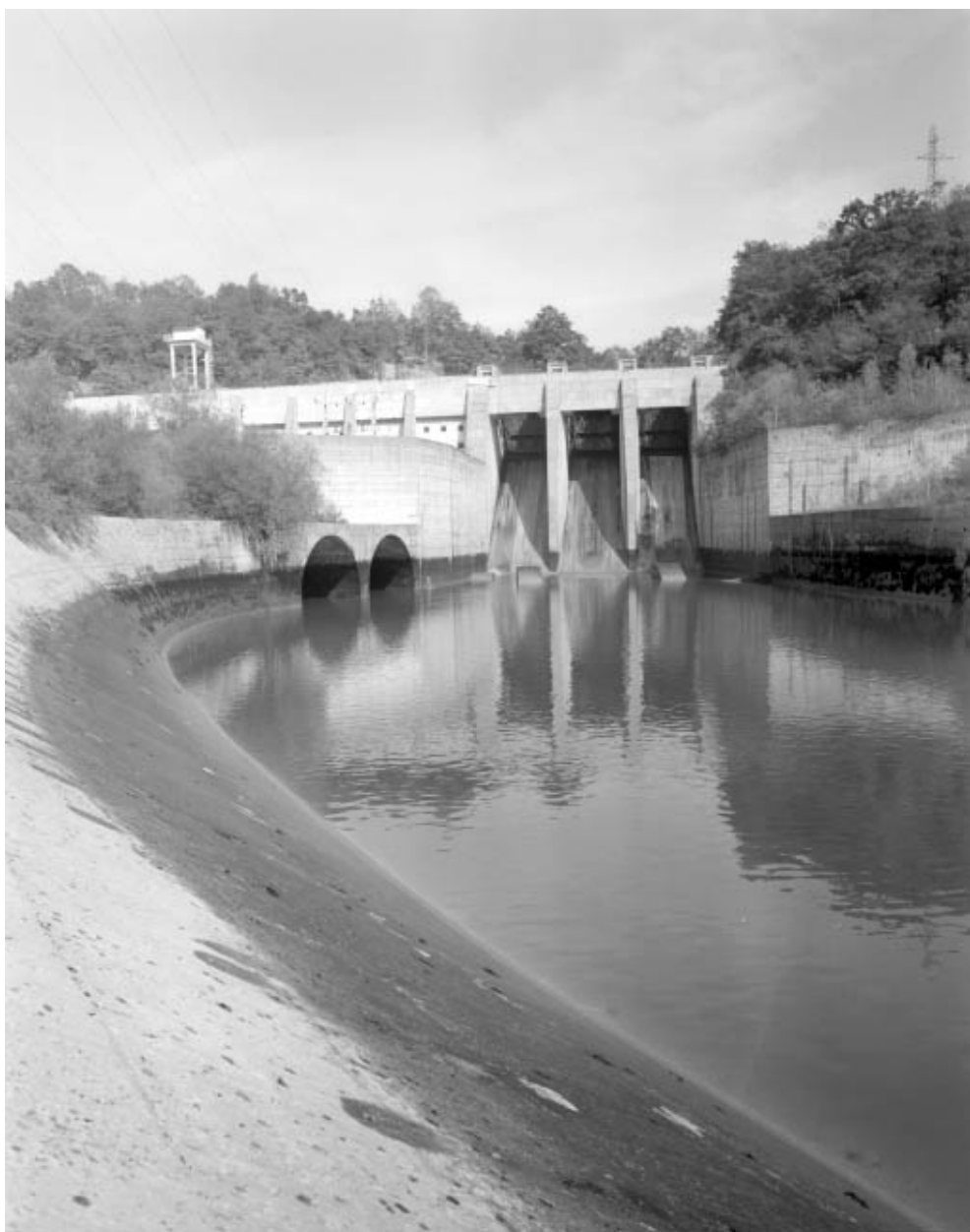
Evacuateur et bassin d'amortissement (cadrage vertical).
