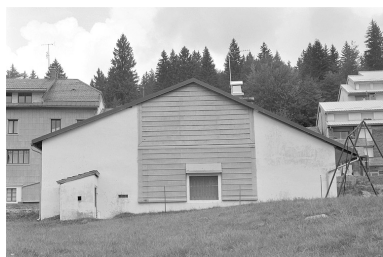
Face sud-ouest. Phot. Jérôme Mongreville IVR43_19963901402X
