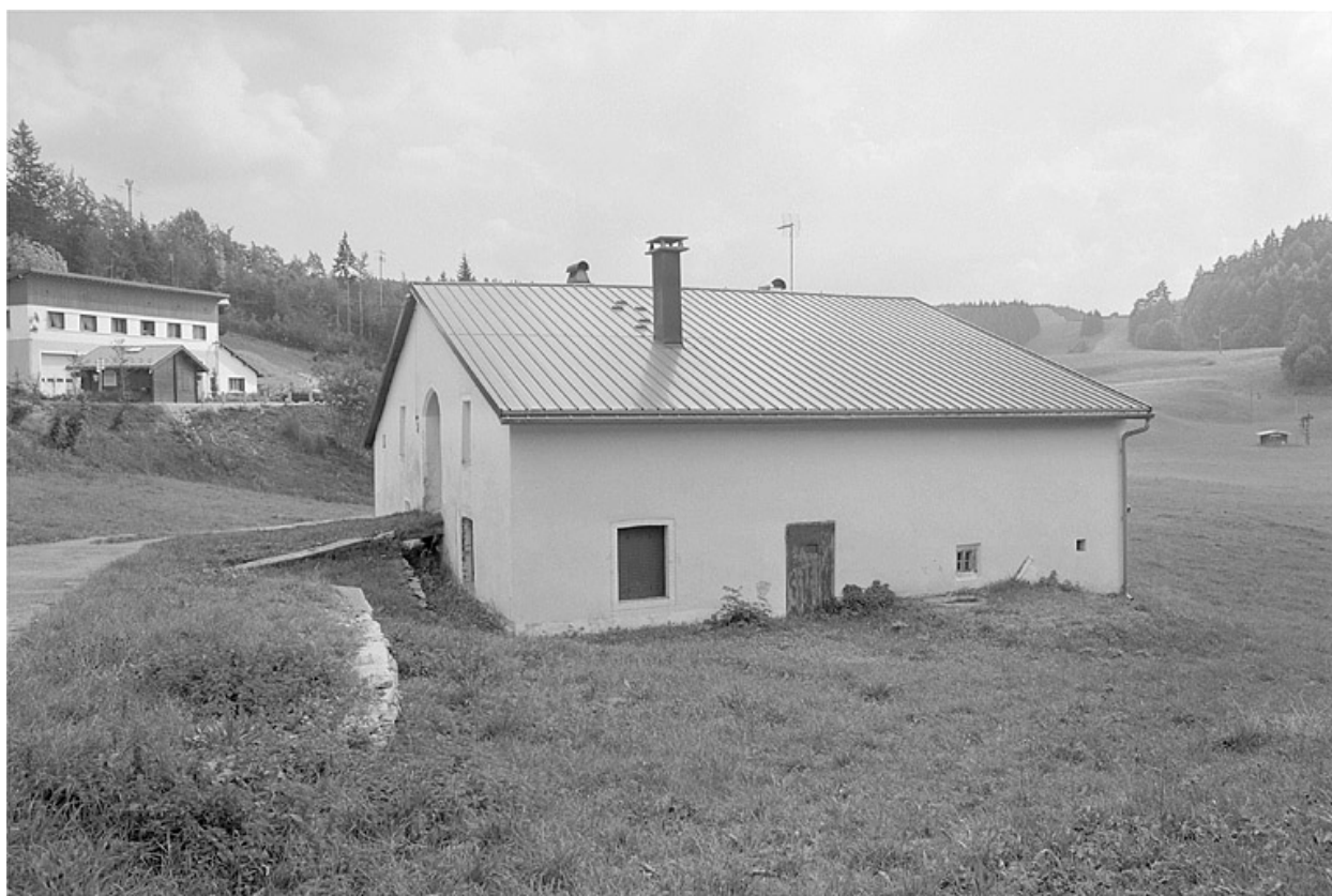
Façade postérieure et face nord-est.
