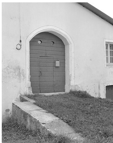
Porte de la grange haute. Phot. Jérôme Mongreville IVR43_19963901401X
