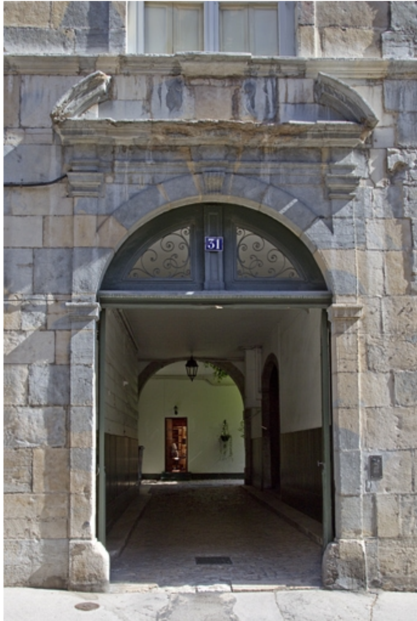
Logis principal : détail du portail d'entrée.
