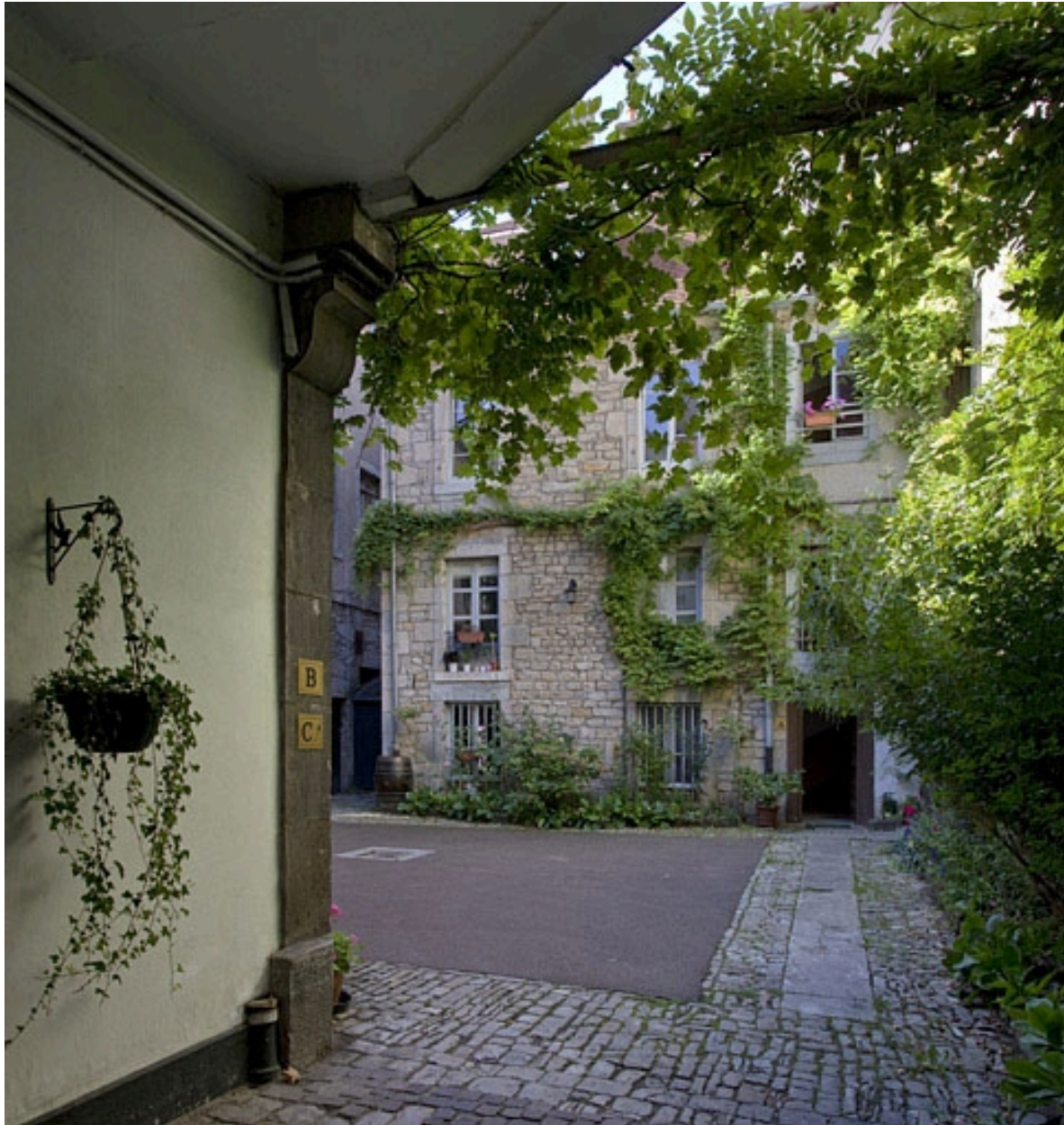
Vue de la cour depuis le passage cocher.
