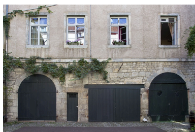
Deuxième logis secondaire : détail des remises du rez-de-chaussée. Phot. Yves Sancey IVR43_20112502807NUC2A
