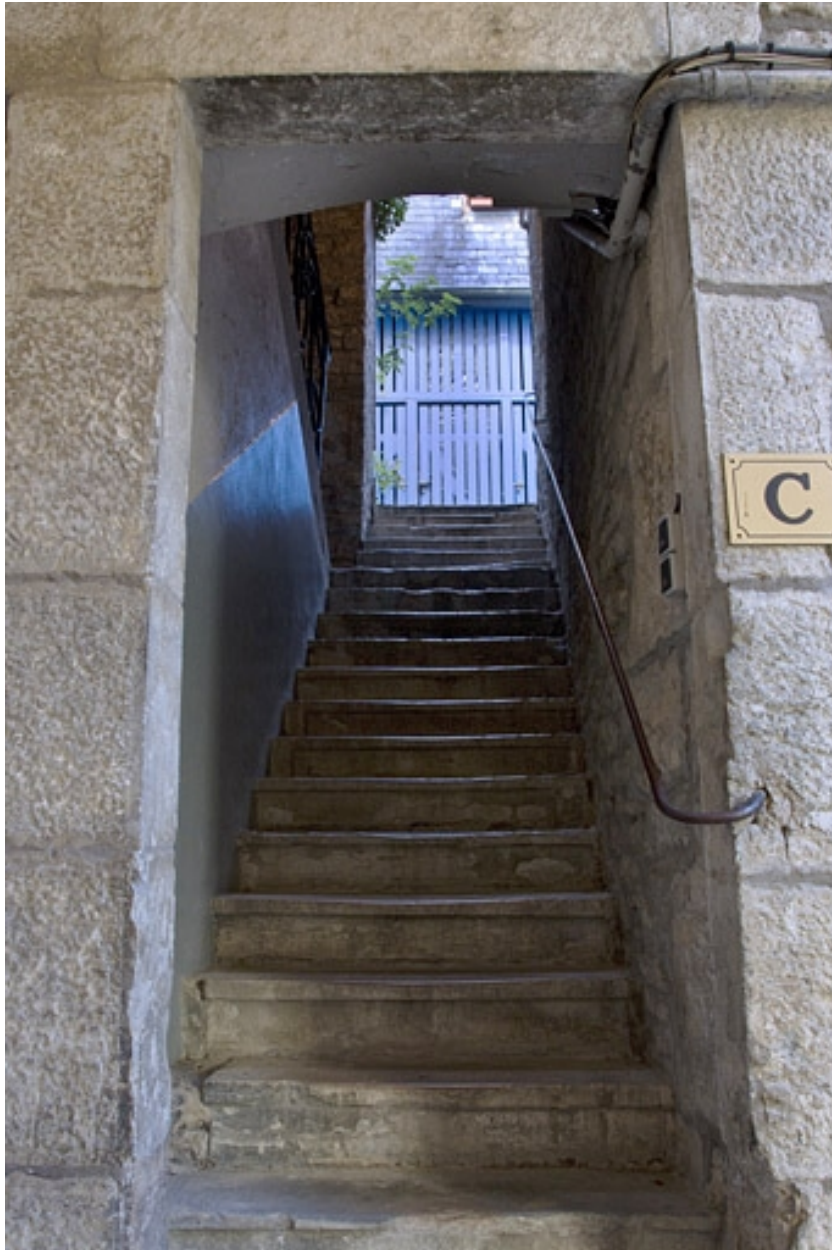
Deuxième logis secondaire : détail de l'escalier à retours sans jour.
