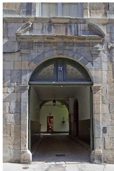
Logis principal : détail du portail d'entrée. Phot. Yves Sancey IVR43_20112502805NUC2A
