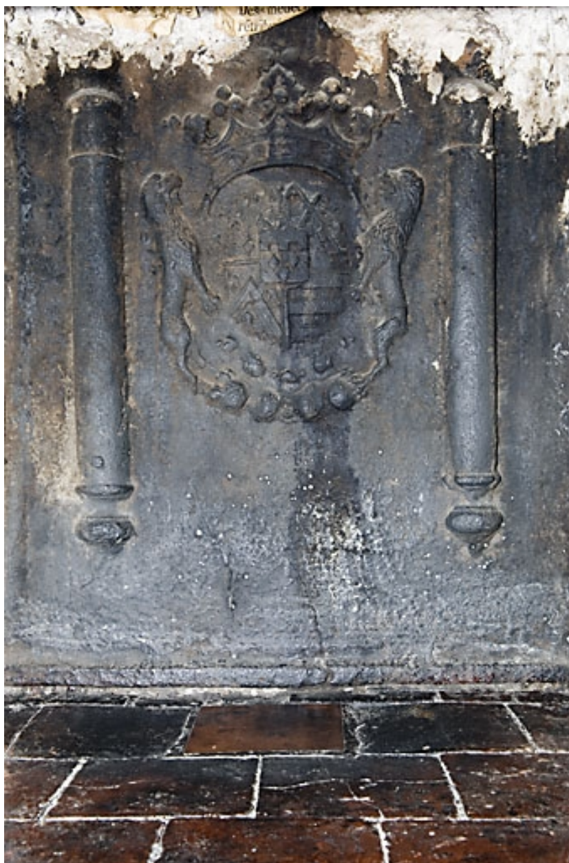
Détail d'une plaque de cheminée du premier étage.
