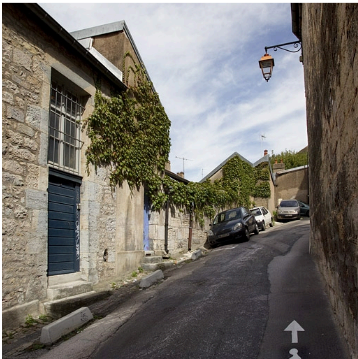
Vue du mur de clôture depuis la rue du Cingle.
