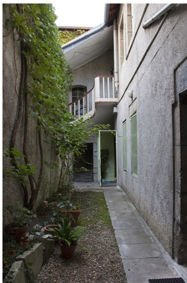
Deuxième logis secondaire : détail de la façade postérieure depuis l'entrée de la deuxième courette. Phot. Yves Sancey IVR43_20112502809NUC2A
