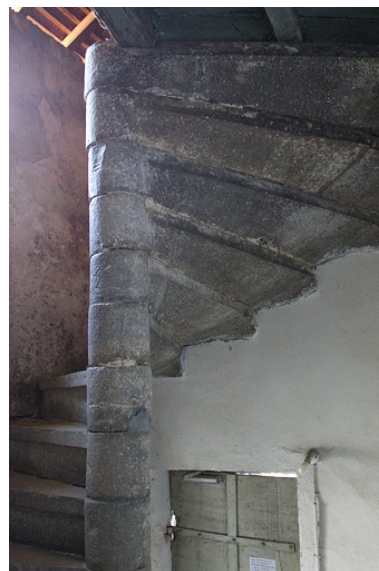
Deuxième logis secondaire : détail d'escalier en vis. Phot. Yves Sancey IVR43_20112502810NUC2A
