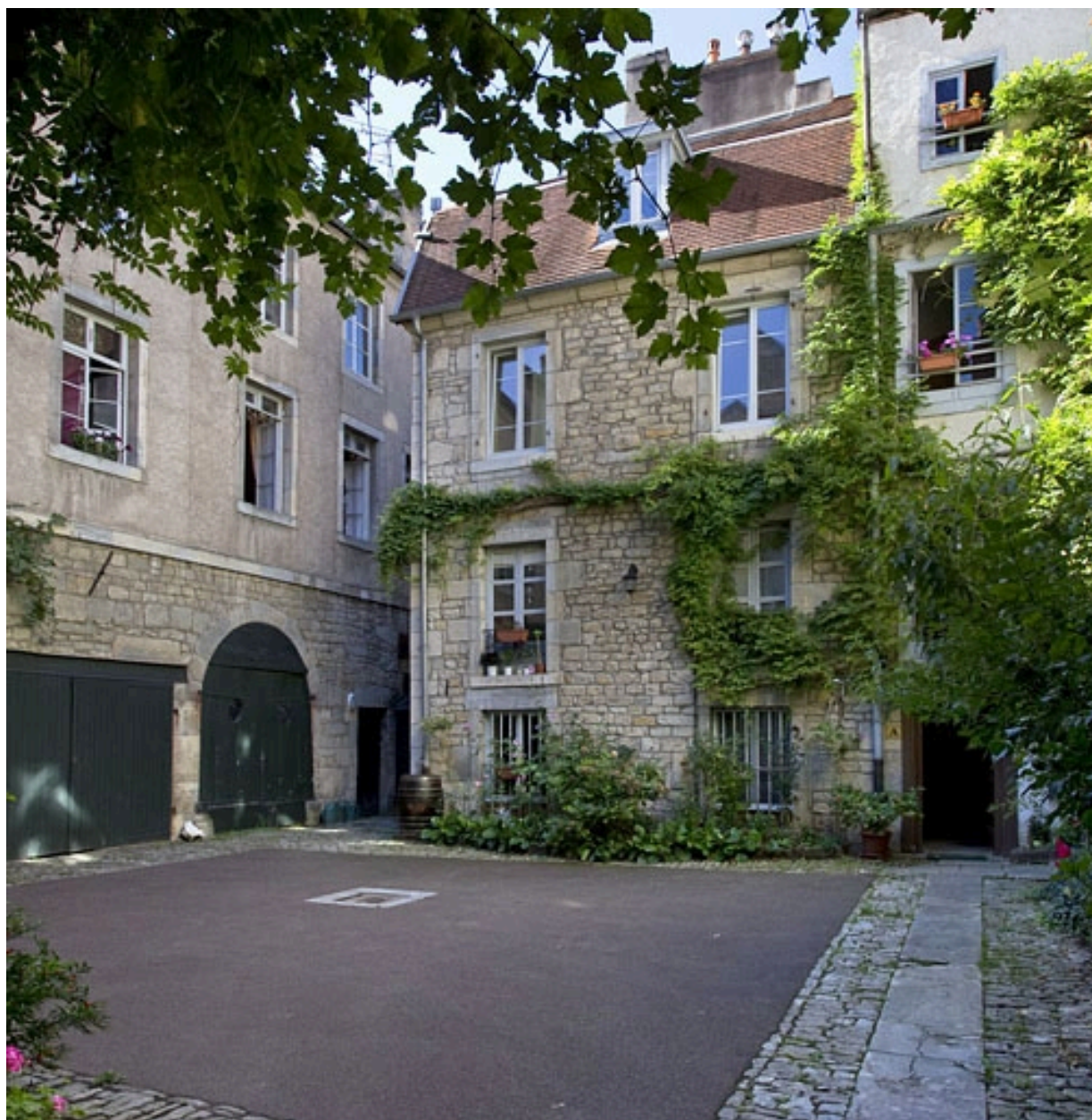
Vue d'ensemble du premier logis secondaire, depuis l'entrée de la cour.
