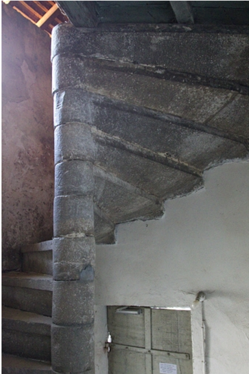
Deuxième logis secondaire : détail d'escalier en vis.
