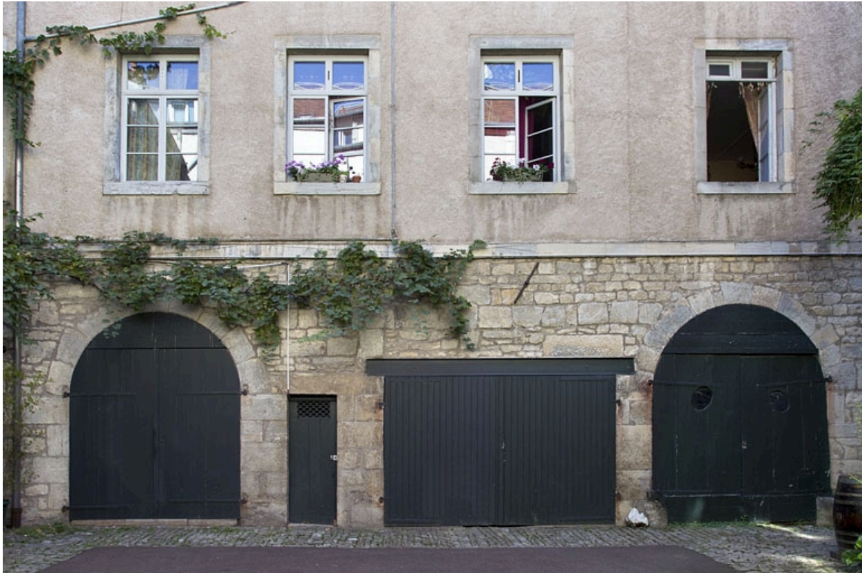
Deuxième logis secondaire : détail des remises du rez-de-chaussée.
