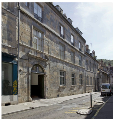
Vue d'ensemble depuis la rue : de trois quarts gauche. Phot. Yves Sancey IVR43_20112502799NUC2A
