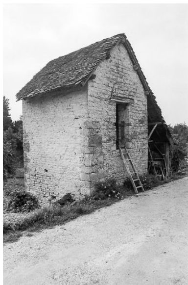
Soue vue de trois quarts gauche. Phot. Gilbert Poinot IVR43_19762500942Z
