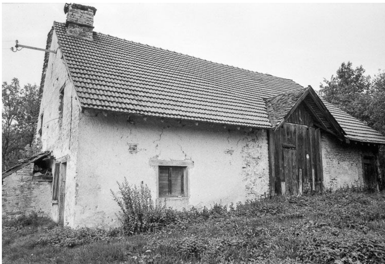
Façade latérale droite.
