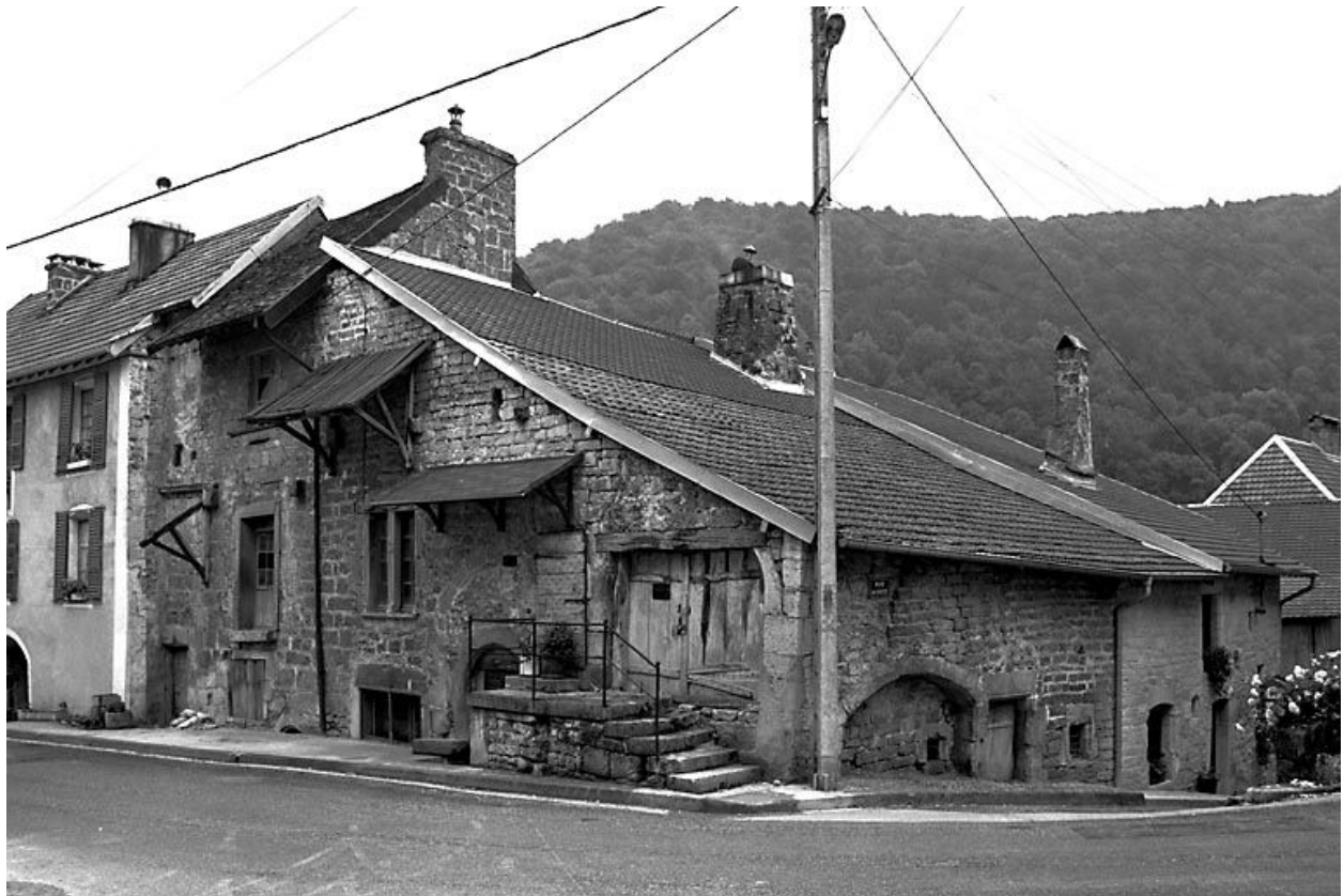
Façade antérieure et façade latérale droite.
