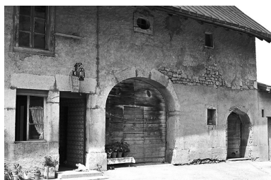
Ferme située 34 avenue des Turquoises : détail de la façade antérieure. Phot. Gilbert Poinot IVR43_19752500979Z
