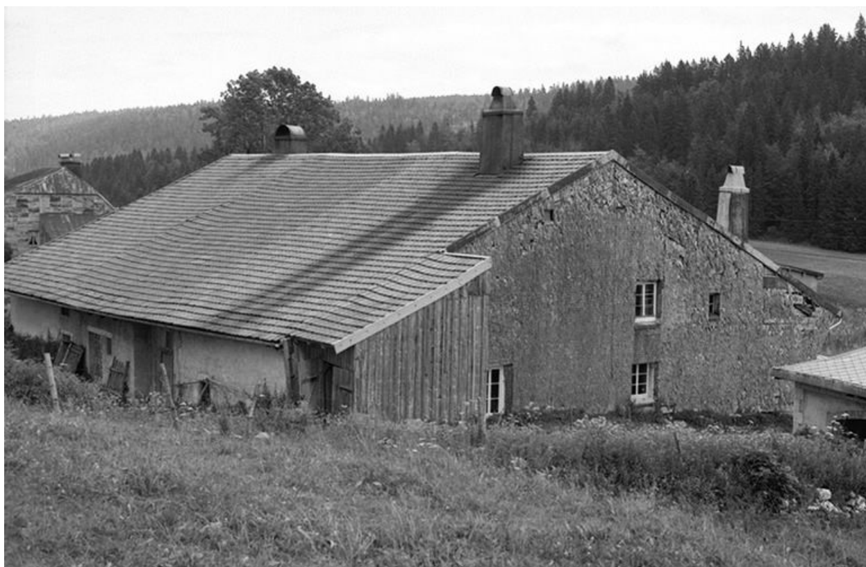
Ferme datée de 1774, située avenue des Turquoises : façade postérieure et pignon gauche.
