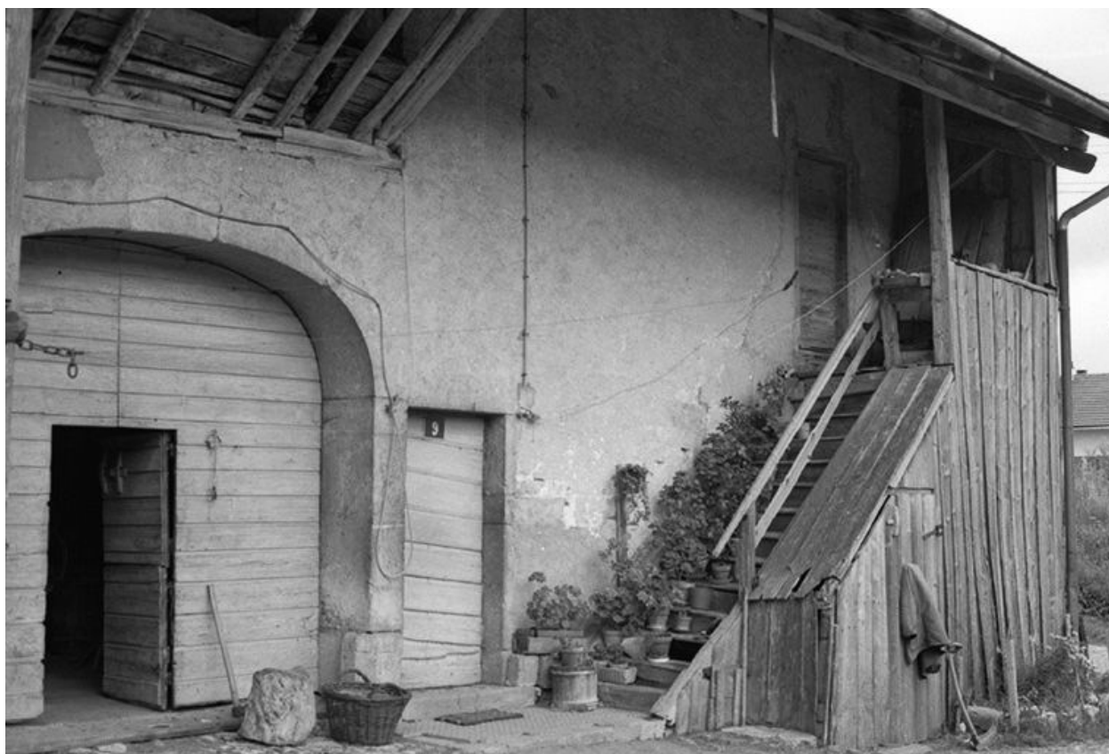
Fermes datées de 1880 et 1706, situées 15 et 15 bis avenue des Turquoises : entrée et porte de grange.
