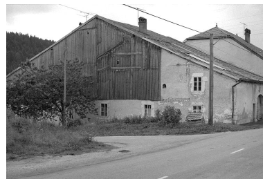
Fermes datées de 1880 et 1706, situées 15 et 15 bis avenue des Turquoises : façades antérieure et latérale gauche. Phot. Gilbert Poinot IVR43_19752500981Z
