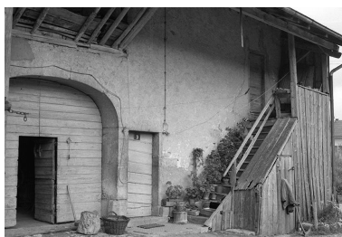
Fermes datées de 1880 et 1706, situées 15 et 15 bis avenue des Turquoises : entrée et porte de grange. Phot. Gilbert Poinot IVR43_19752500980Z
