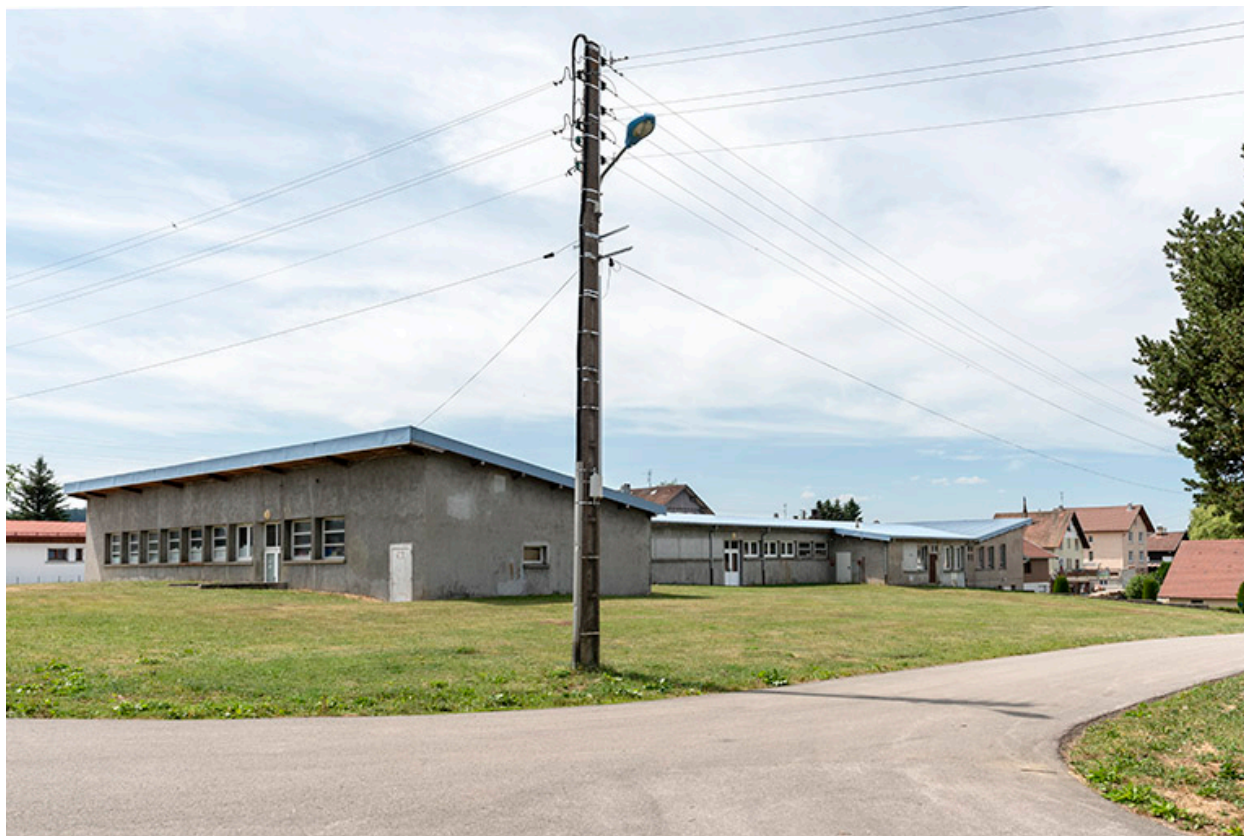
Façades postérieure et latérale droite.
