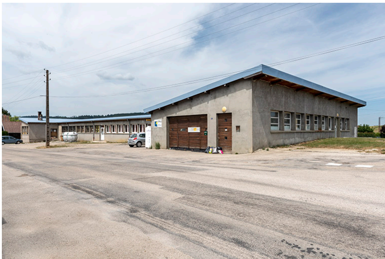
Façades antérieure et latérale droite.
