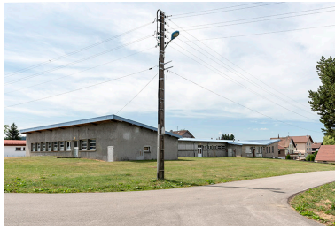
Façades postérieure et latérale droite.
