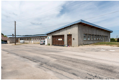
Façades antérieure et latérale droite.
