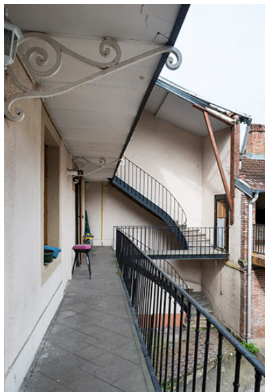
Escalier à cage ouverte, façade postérieure. Phot. Jérôme Mongreville IVR43_20177000474NUC4A
