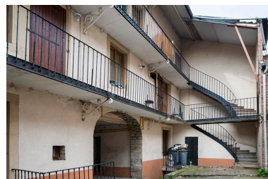
Façade postérieure. Phot. Jérôme Mongreville IVR43_20177000473NUC4A
