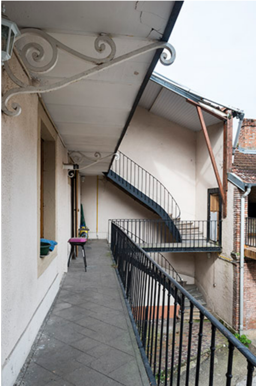
Escalier à cage ouverte, façade postérieure.
