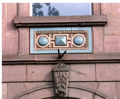
Façade principale, avant-corps, allège en céramique d'une fenêtre du premier étage. Phot. Jérôme Mongreville IVR43_19872500574XA
