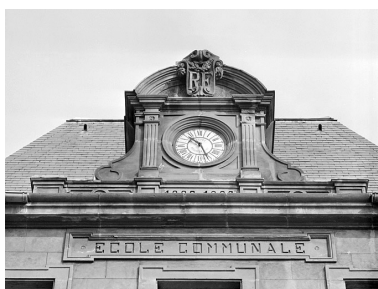
Façade principale, détail de l'horloge. Phot. Jérôme Mongreville IVR43_19872500812X
