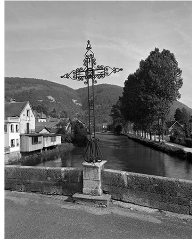
Vue générale de la croix monumentale. Phot. Yves Sancey IVR43_19802501337X
