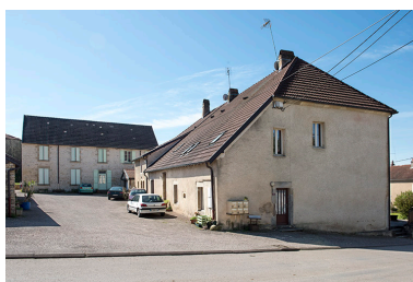
Vue d'ensemble depuis la voie publique. Phot. Sonia Dourlot
