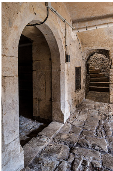
Escalier d'accès au rez- de-chaussée de la maison. Phot. Jérôme Mongreville IVR43_20177000115NUC4A
