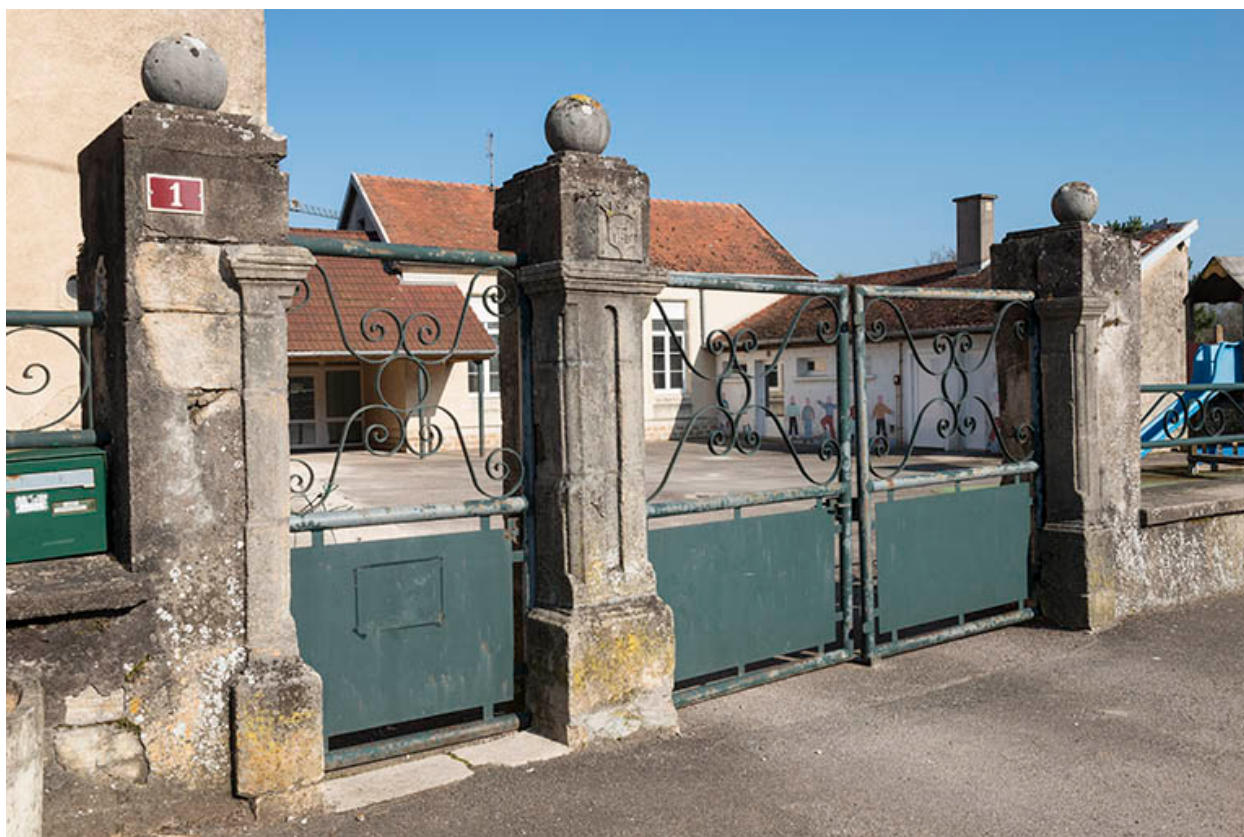
L'entrée depuis la rue.
