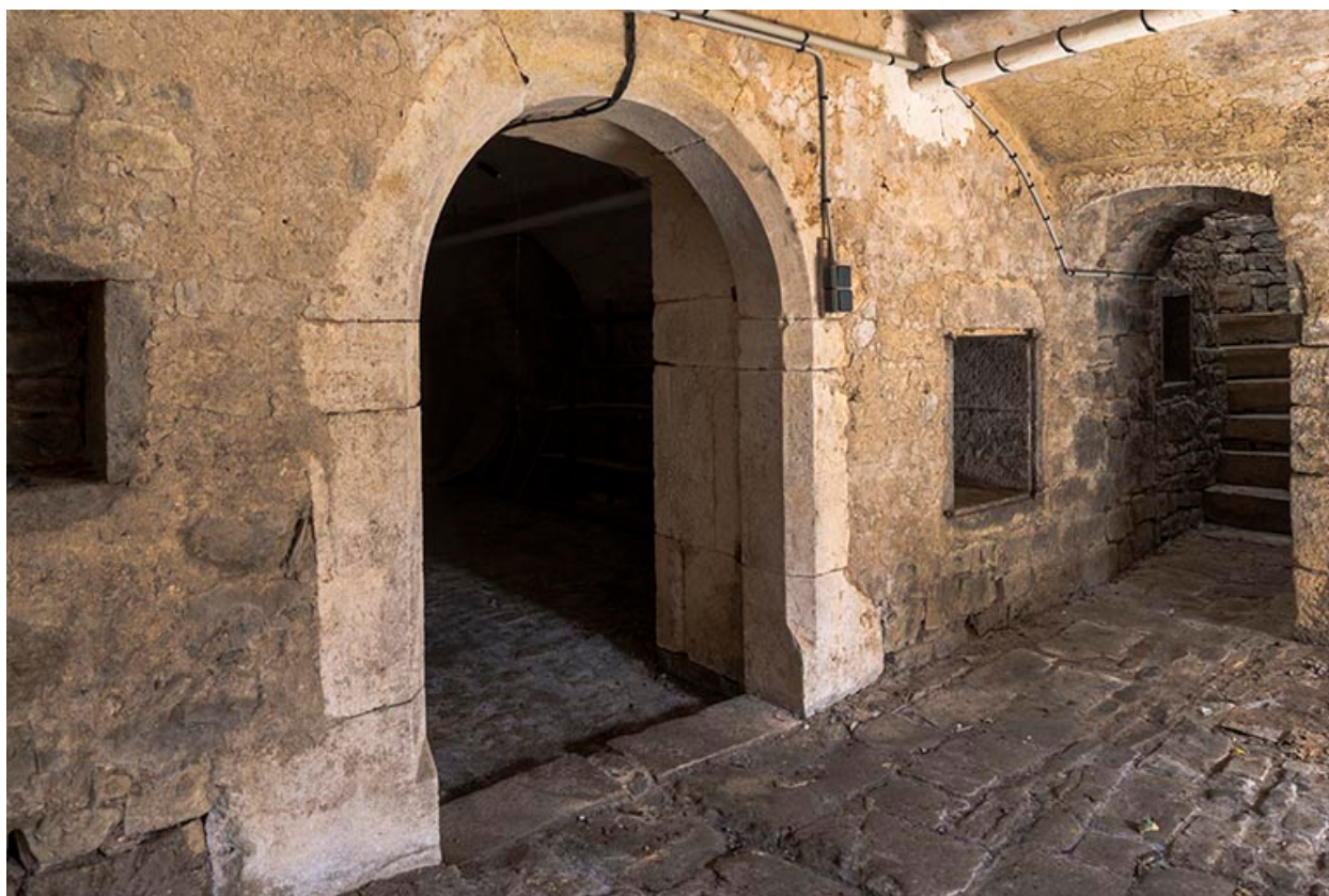
Porte de séparation de la cave.
