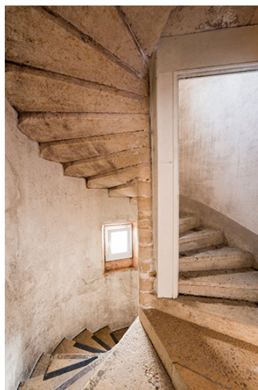
Escalier à vis, situé dans la tour. Phot. Jérôme Mongreville IVR43_20177000110NUC4A
