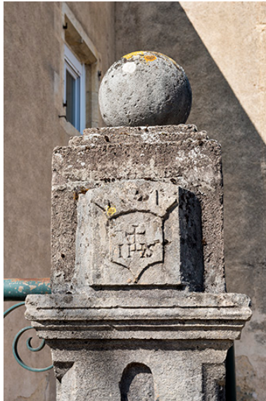
Détail d'un pilier. Phot. Jérôme Mongreville IVR43_20177000176NUC4A
