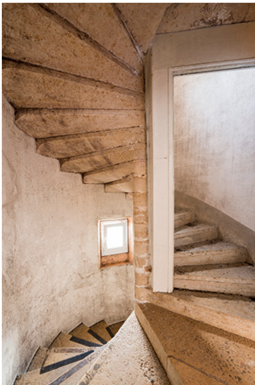
Escalier à vis, situé dans la tour.
