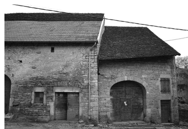
Ferme cadastrée 1965 AB 179 : façade antérieure. Phot. F. Pernin IVR43_19743900131Z
