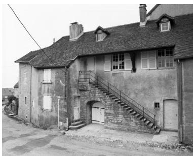
Maison située Grande Rue : façade antérieure. Phot. Yves Sancey IVR43_19813900052X
