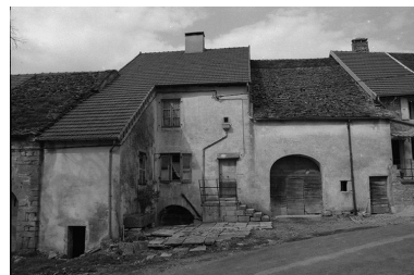
Ferme située rue de l'Eglise : façade antérieure. Phot. F. Pernin IVR43_19743900130Z
