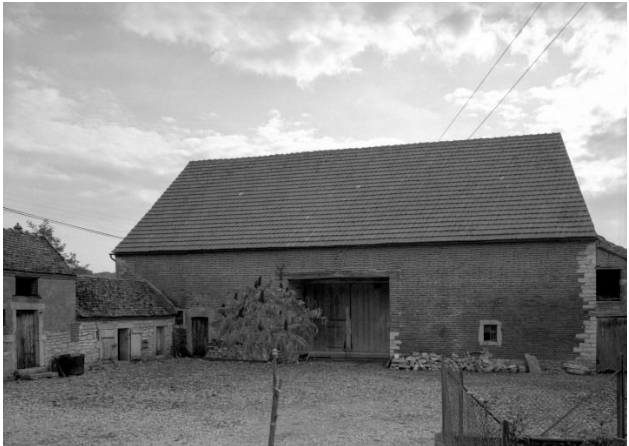
Bâtiment des dépendances.
