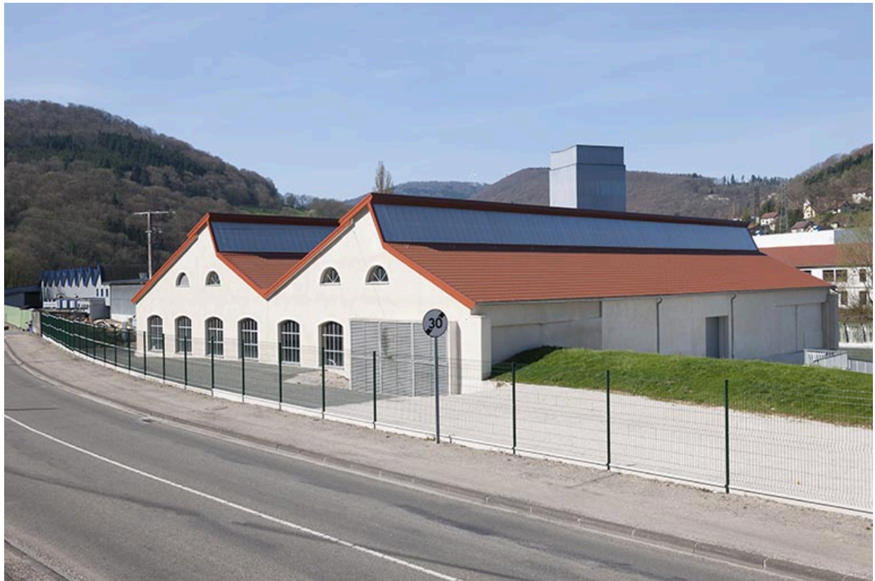
Centrale hydroélectrique (rive droite).
