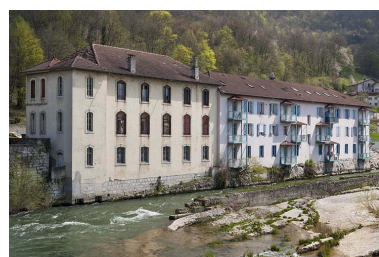
Façades sur la rivière des bâtiments de bureaux. Phot. Jérôme Mongreville IVR43_20132500300NUC4A
