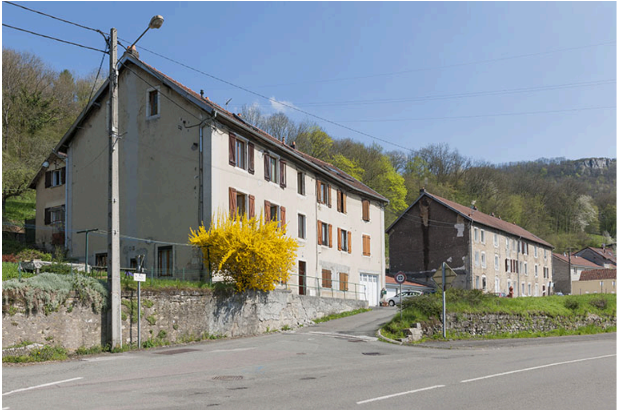
Logements ouvriers (route de Chatey).
