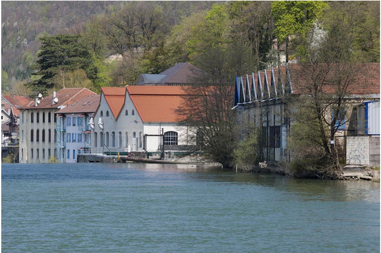
Vue de l'usine rive droite depuis l'amont.
