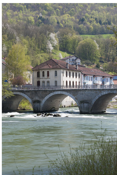
Bâtiments de la rive droite depuis l'aval du pont. Phot. Jérôme Mongreville IVR43_20132500302NUC4A
