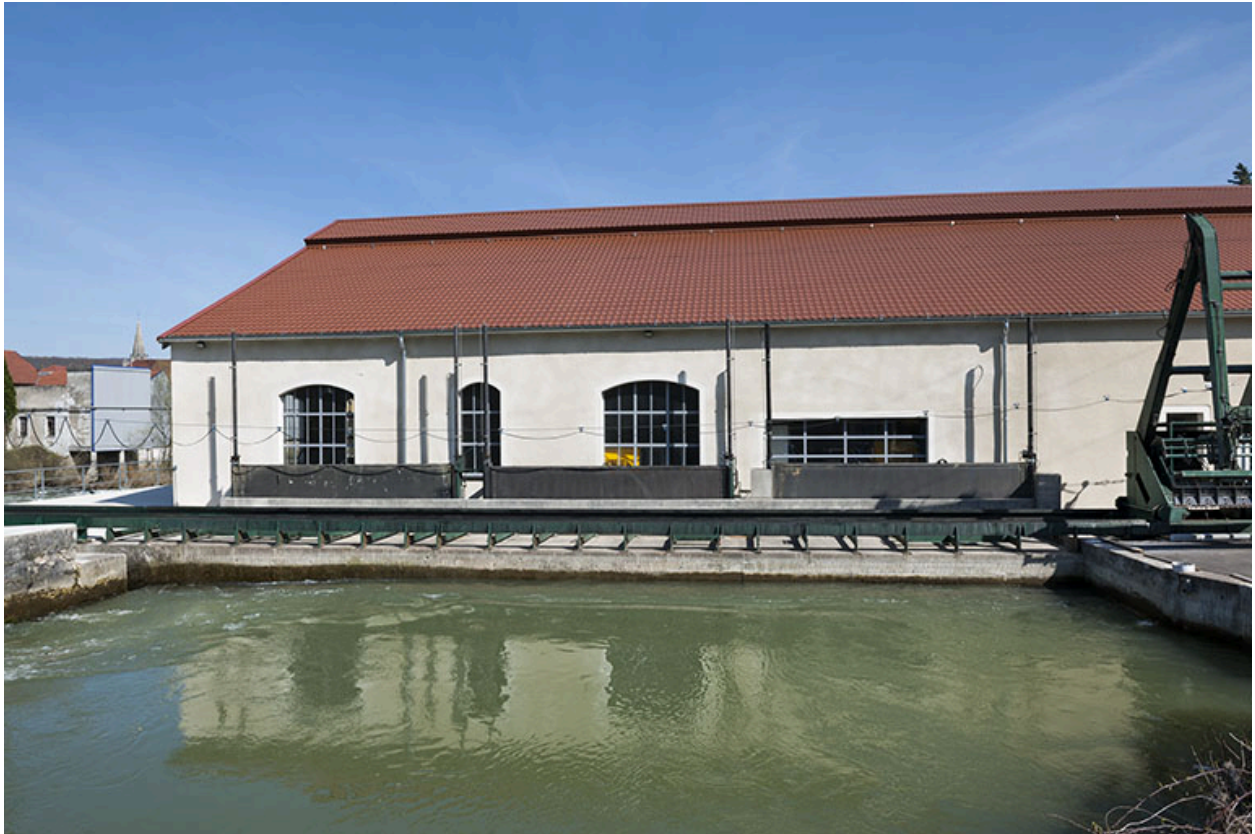
Bief d'amenée de la centrale hydroélectrique.
