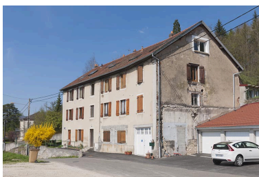
Logement ouvrier nord. Phot. Jérôme Mongreville IVR43_20132500287NUC4A
