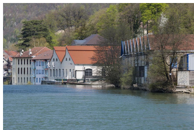
Vue de l'usine rive droite depuis l'amont. Phot. Jérôme Mongreville IVR43_20132500298NUC4A
