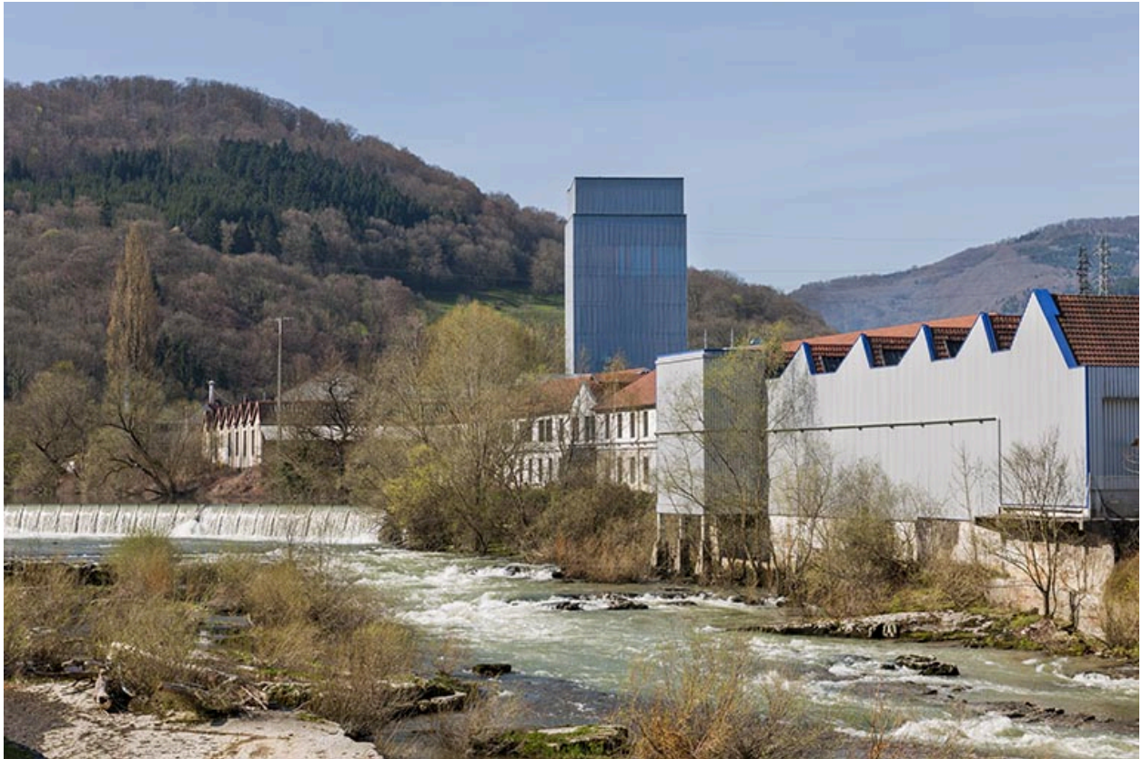
Usine rive gauche. Vue depuis le pont.
