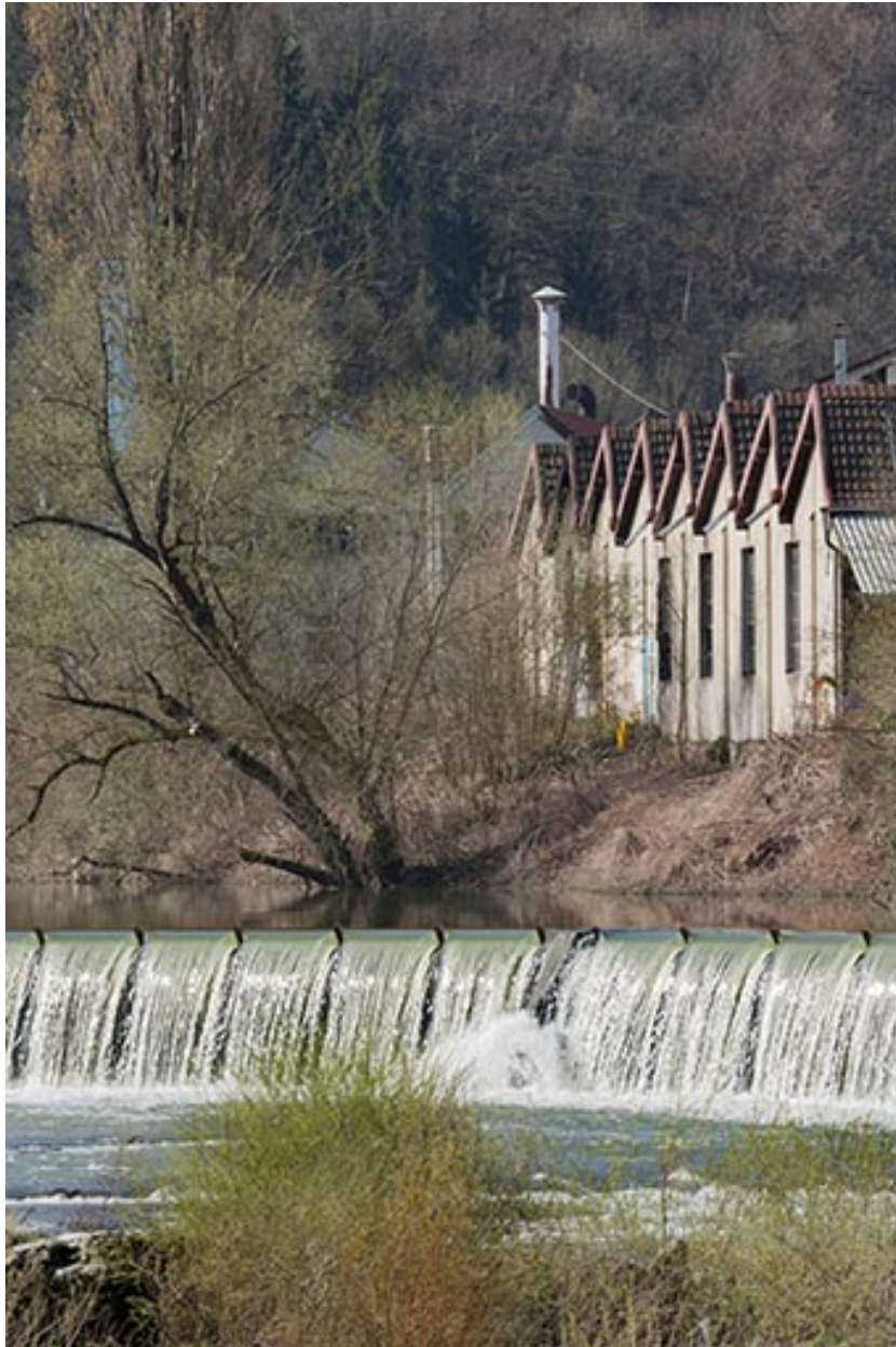
Détail du barrage et des ateliers rive gauche.
