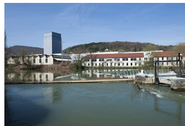
Vue d'ensemble des bâtiments de la rive gauche. Phot. Jérôme Mongreville IVR43_20132500159NUC4A
