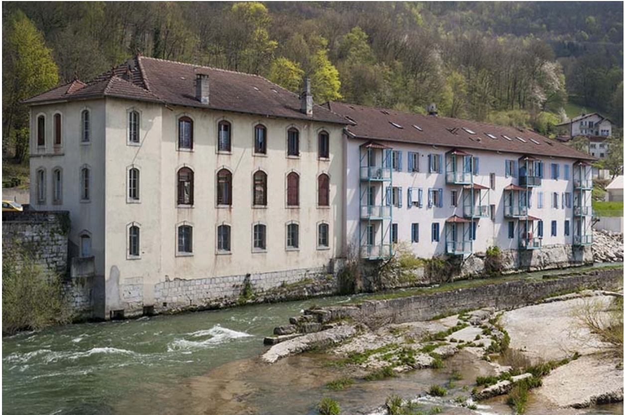
Façades sur la rivière des bâtiments de bureaux.
