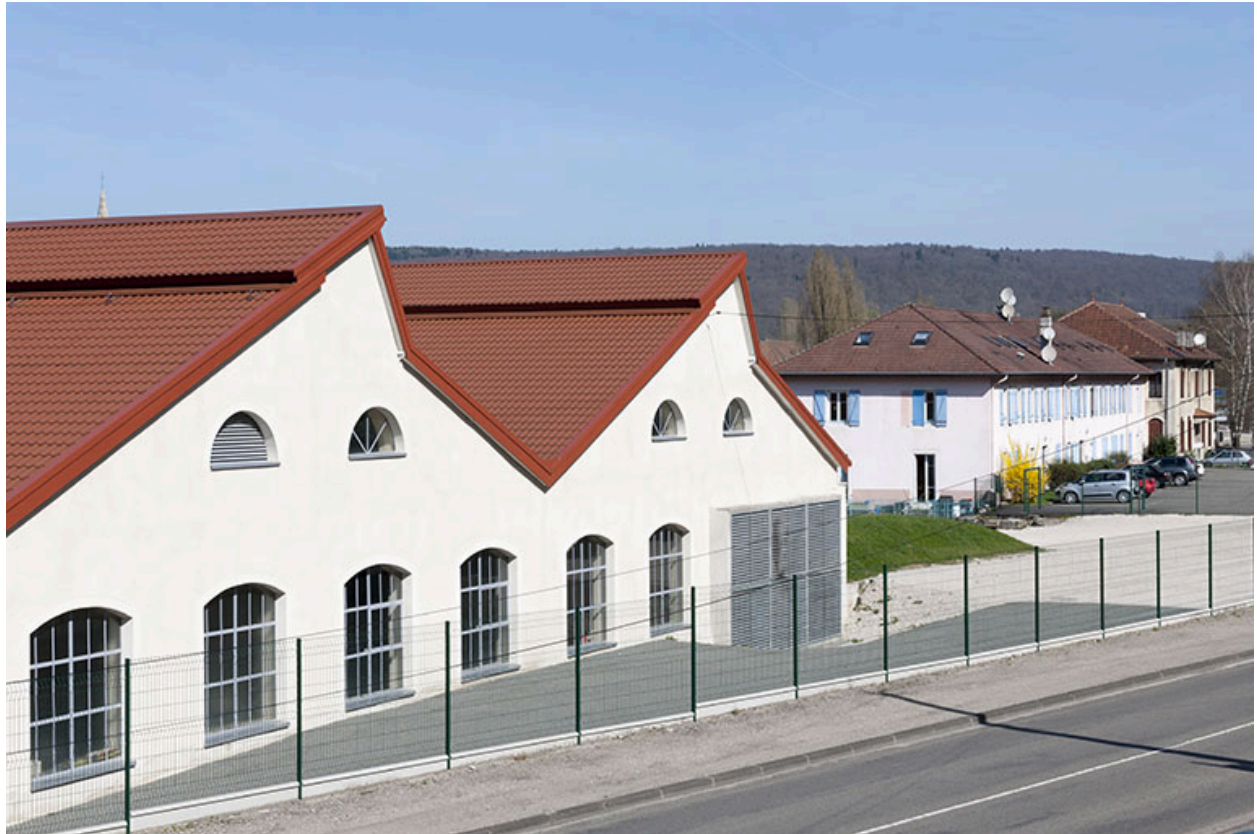
Pignons de la centrale hydroélectrique.
