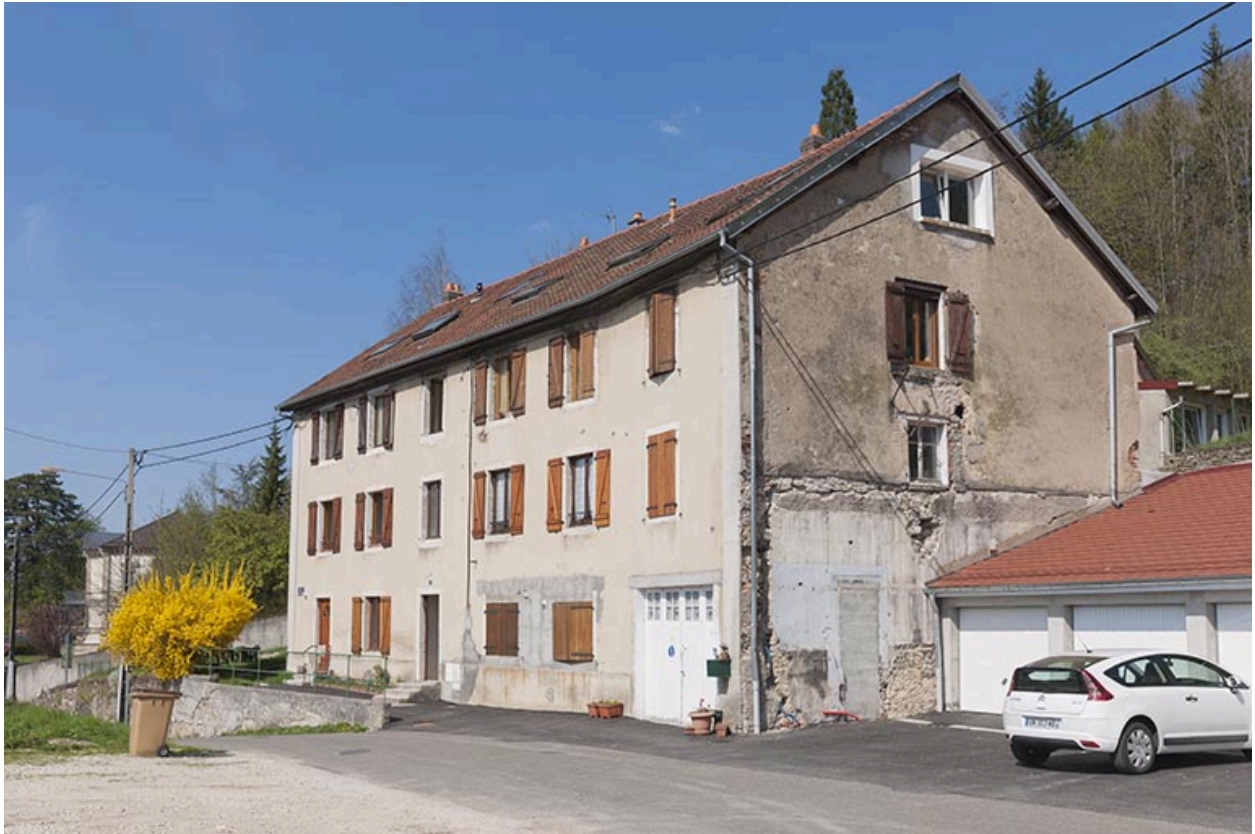
Logement ouvrier nord.
