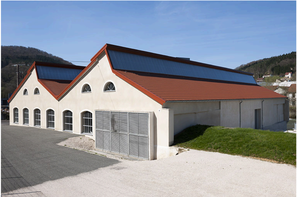
La centrale hydroélectrique vue de trois quarts droite.
