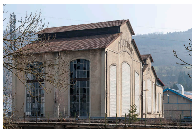
La centrale thermique vue de trois quarts arrière. Phot. Jérôme Mongreville IVR43_20152500405NUC4A
