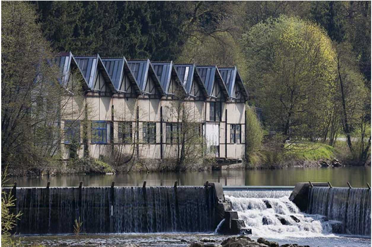
Ateliers sud de la rive droite.
