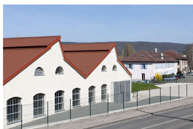
Pignons de la centrale hydroélectrique. Phot. Jérôme Mongreville IVR43_20132500155NUC4A
