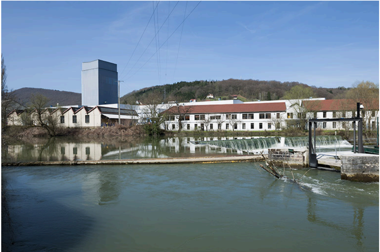
Vue d'ensemble des bâtiments de la rive gauche.
