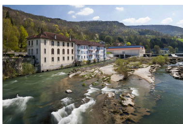
Usine rive droite depuis le pont. Phot. Jérôme Mongreville IVR43_20132500299NUC4A
