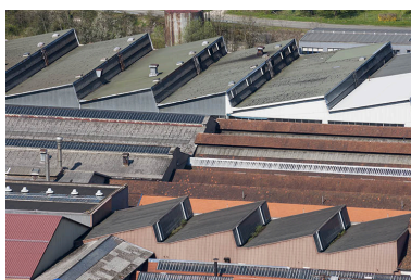
Détail de toitures des bâtiments industriels. Phot. Jérôme Mongreville IVR43_20132500292NUC4A
