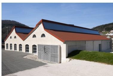
La centrale hydroélectrique vue de trois quarts droite. Phot. Jérôme Mongreville IVR43_20132500163NUC4A
