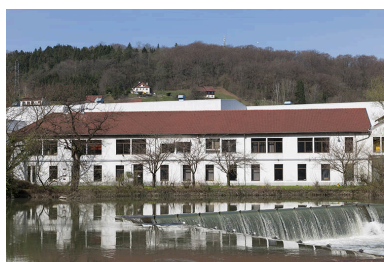
Bâtiment industriel de la rive gauche. Phot. Jérôme Mongreville IVR43_20132500160NUC4A
