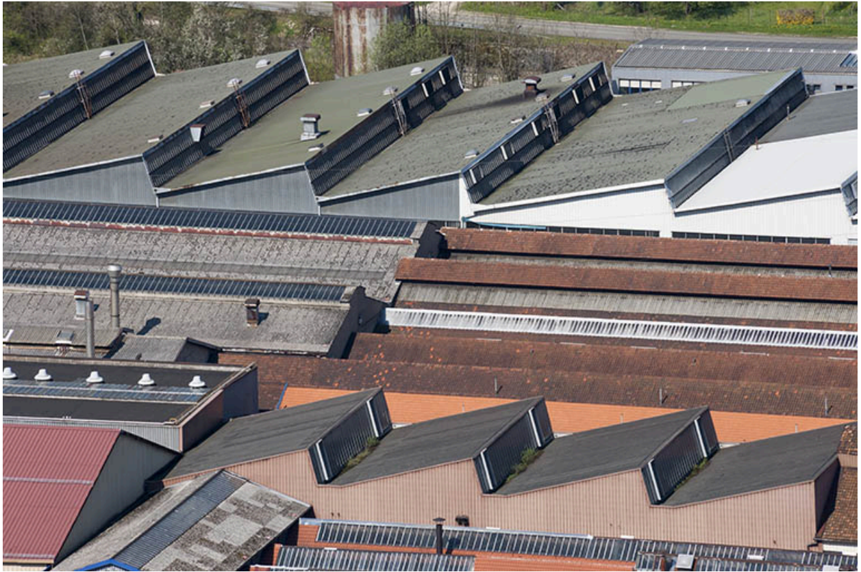
Détail de toitures des bâtiments industriels.
