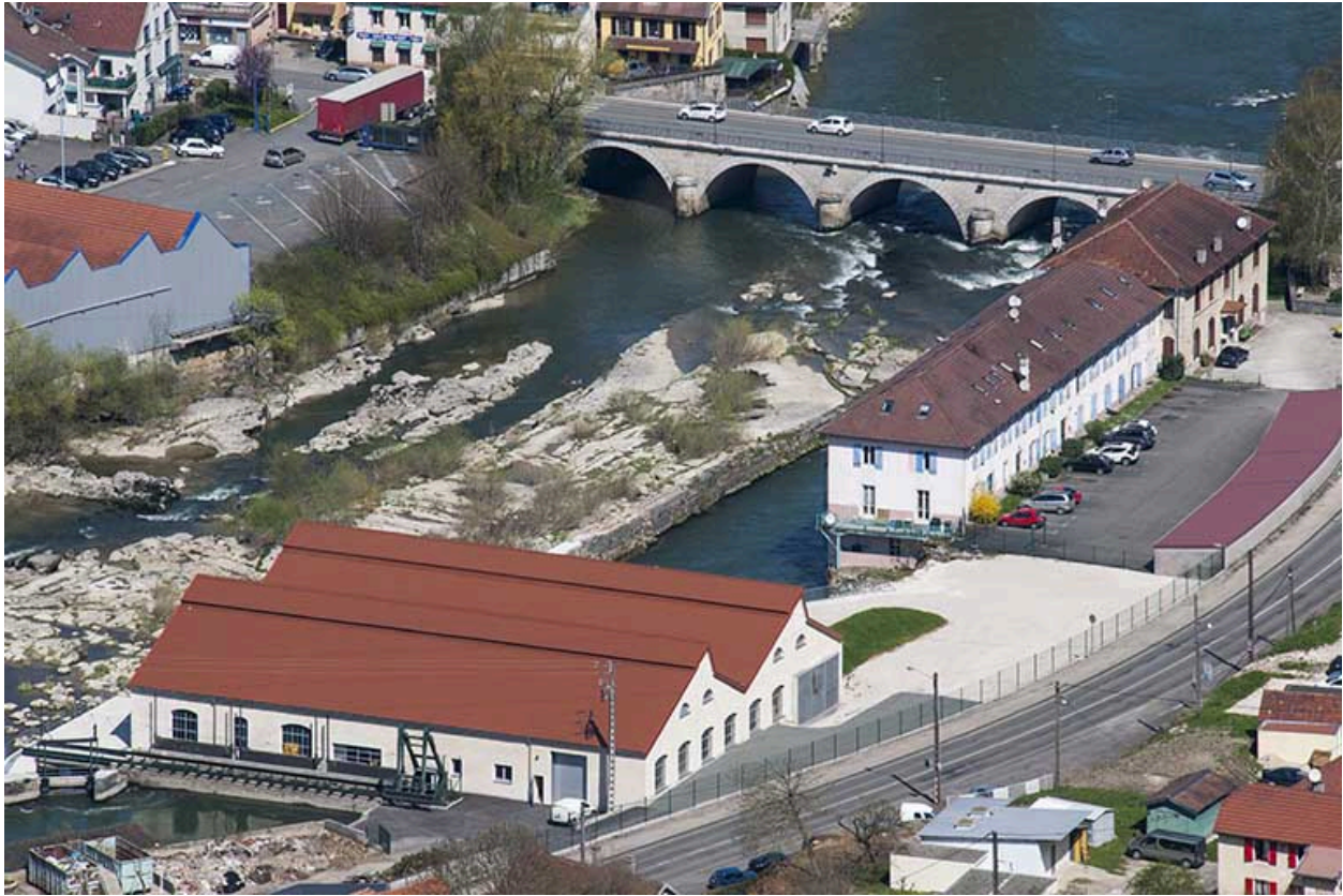
Bâtiments de bureaux en aval du site.
