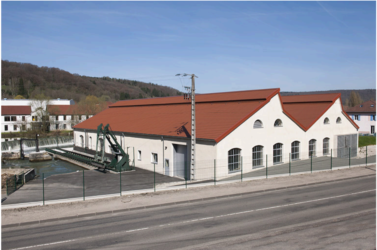
La centrale hydroélectrique vue de trois quarts.
