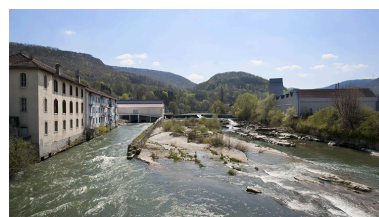
Vue d'ensemble depuis le pont. Phot. Jérôme Mongreville IVR43_20132500304NUC4A
