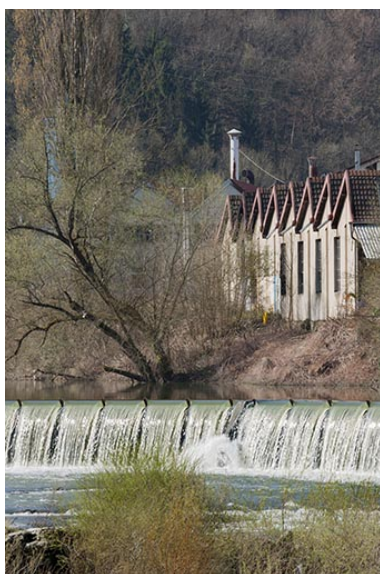
Détail du barrage et des ateliers rive gauche. Phot. Jérôme Mongreville IVR43_20132500149NUC4A
