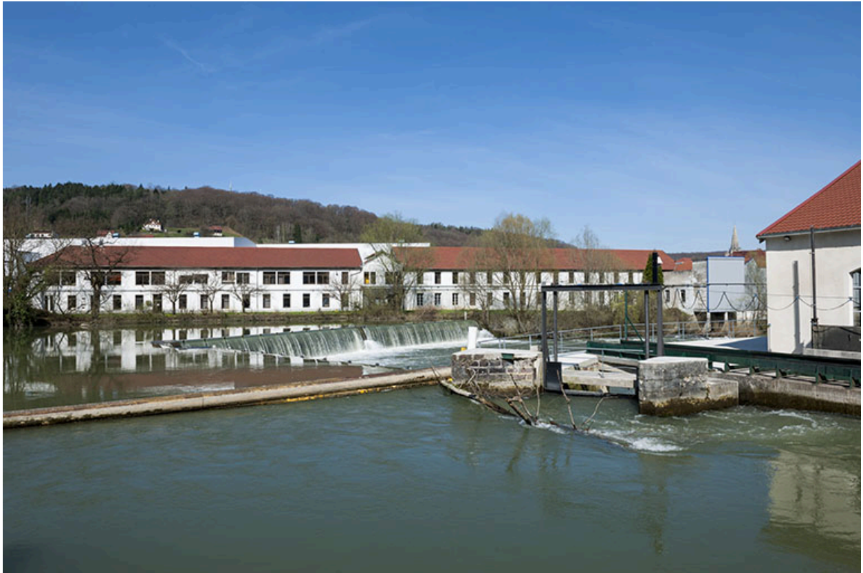
Usine (rive gauche) depuis l'est.
