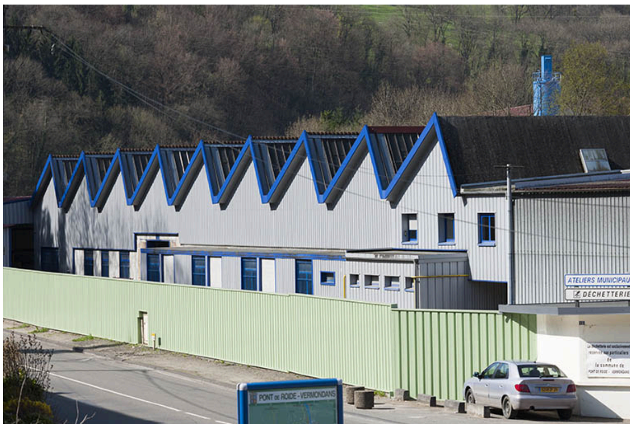
Ateliers sud de la rive droite.
