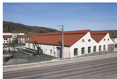
La centrale hydroélectrique vue de trois quarts. Phot. Jérôme Mongreville IVR43_20132500156NUC4A
