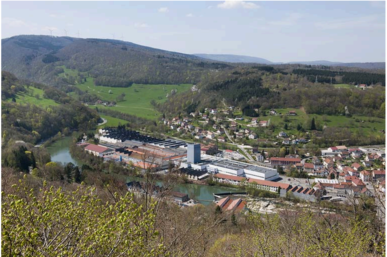
Vue plongeante depuis le nord-est.
