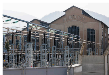
La centrale thermique. Phot. Jérôme Mongreville IVR43_20152500404NUC4A
