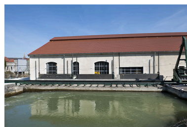
Bief d'amenée de la centrale hydroélectrique. Phot. Jérôme Mongreville IVR43_20132500162NUC4A
