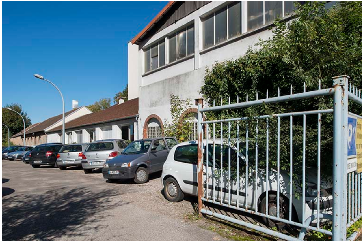
Ateliers de la fonderie. Façades ouest.
