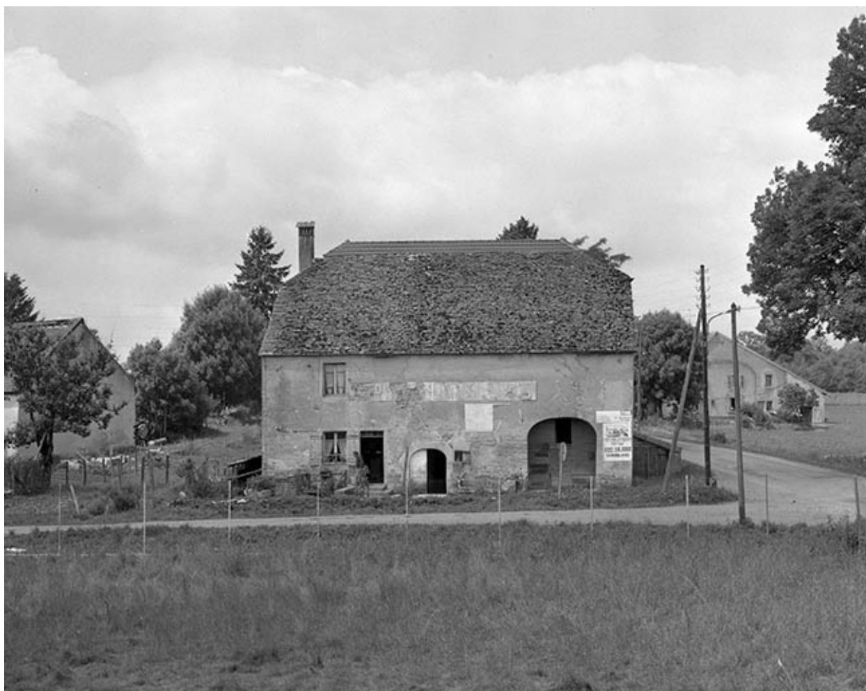
Façade antérieure, vue de face.
