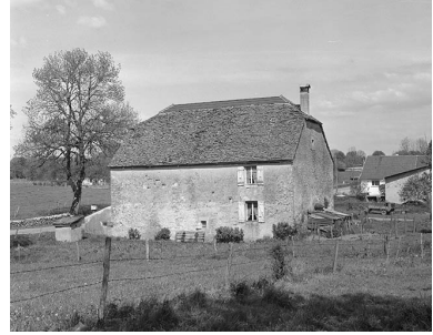
Façade postérieure. Phot. Yves Sancey IVR43_19813900131X
