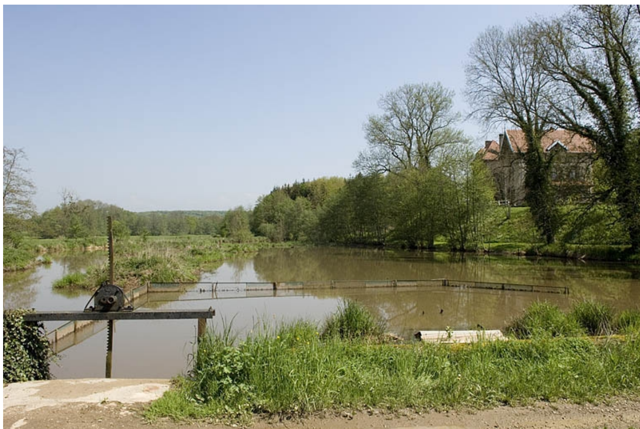
Bassin de retenue.
