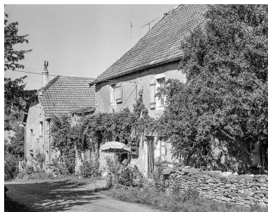
Ferme située rue des Corvées. Phot. Dominique Dominguez IVR43_19807000137X
