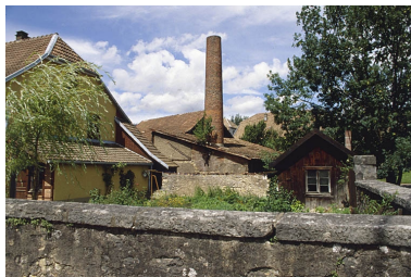
Vue en amont de la Batte.
