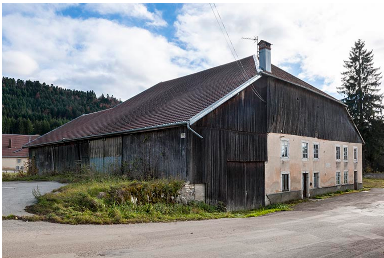
Vue depuis le nord.
