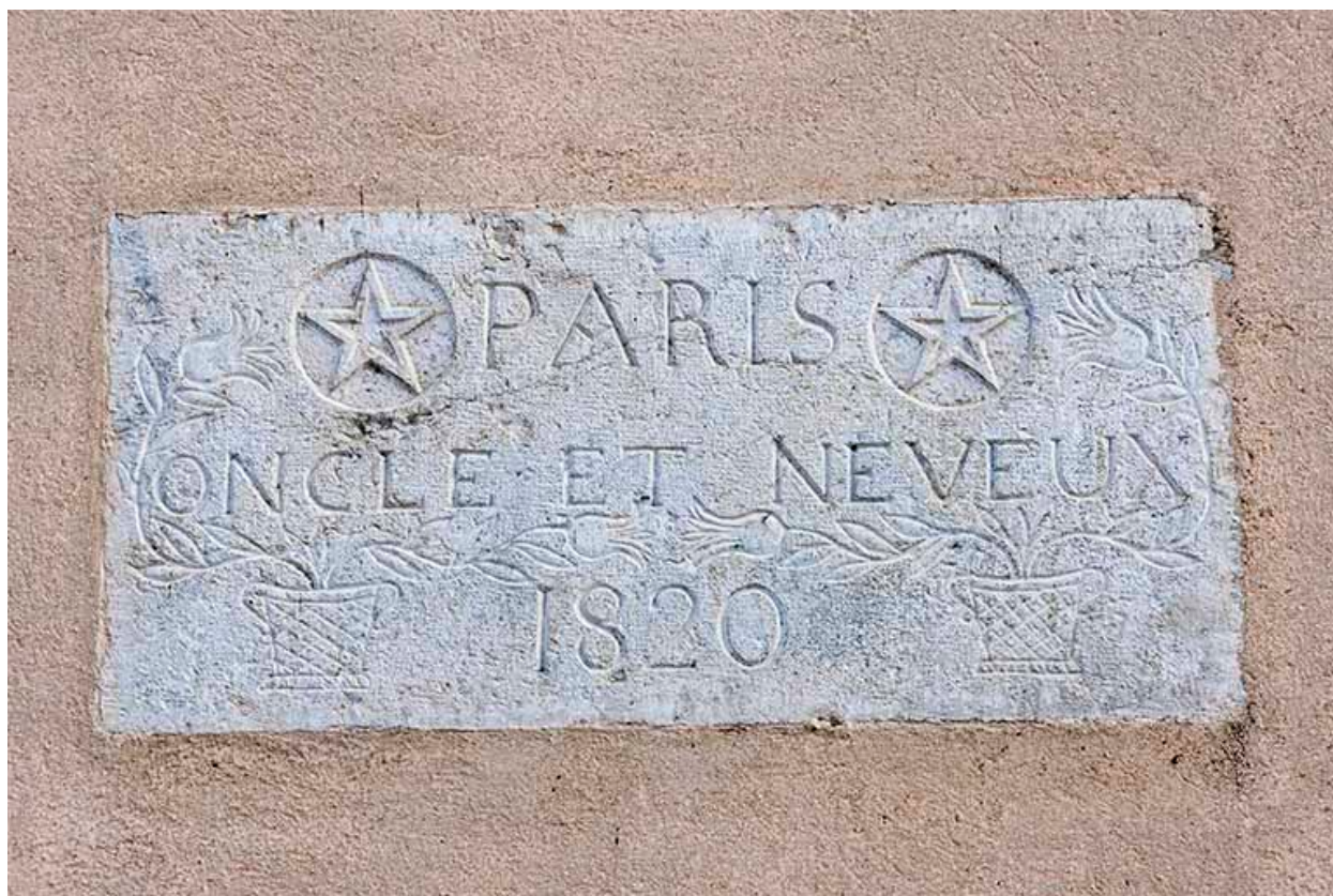
Pierre gravée sur la façade nord.
