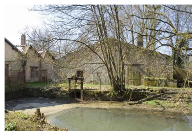
Bief d'amenée et pignon de l'entrepôt industriel (?). Phot. Jérôme Mongreville IVR43_20097000277NUC2A
