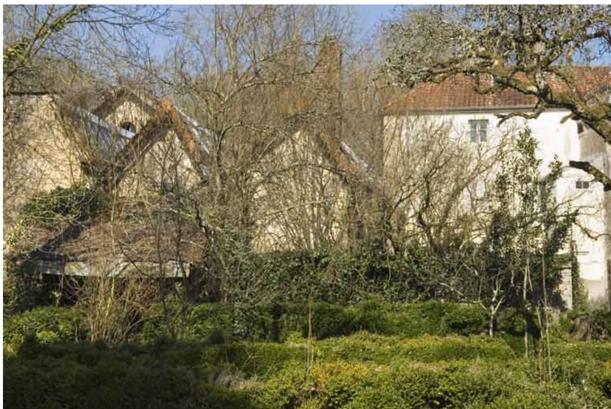
Atelier de fabrication et logement depuis l'ouest.
