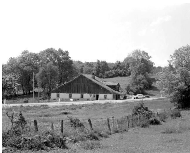
Ferme située à Aubonne Phot. Bernard Lardière IVR43_19782500228X
