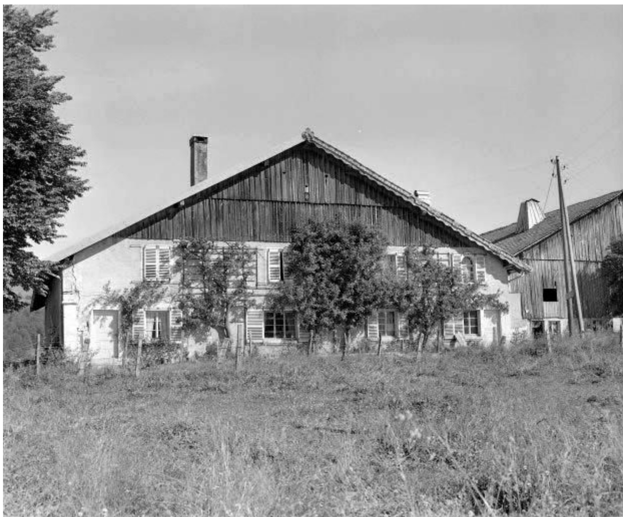
Ferme située à Bugny.
