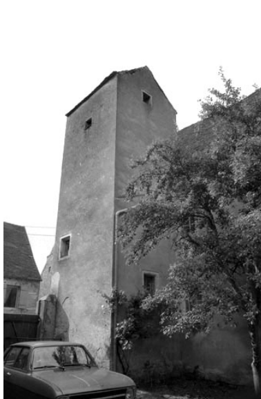
Façade sur impasse. Phot. Bernard Lardière IVR43_19817000815Z
