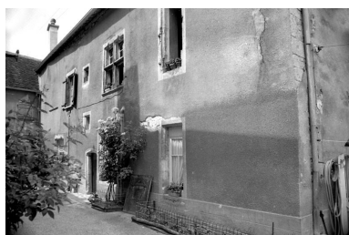
Façade sur impasse. Phot. Bernard Lardière IVR43_19817000814Z
