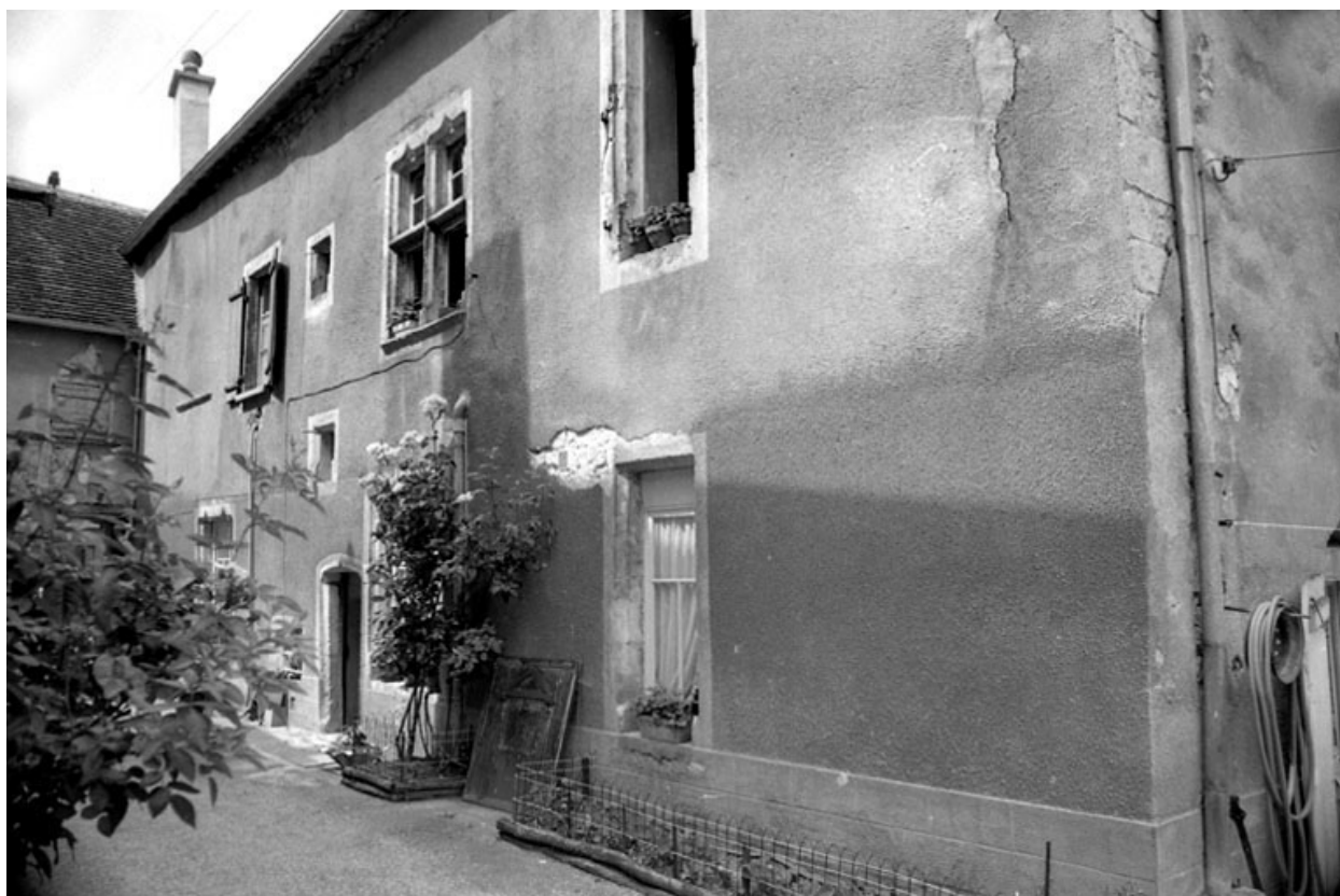
Façade sur impasse.
