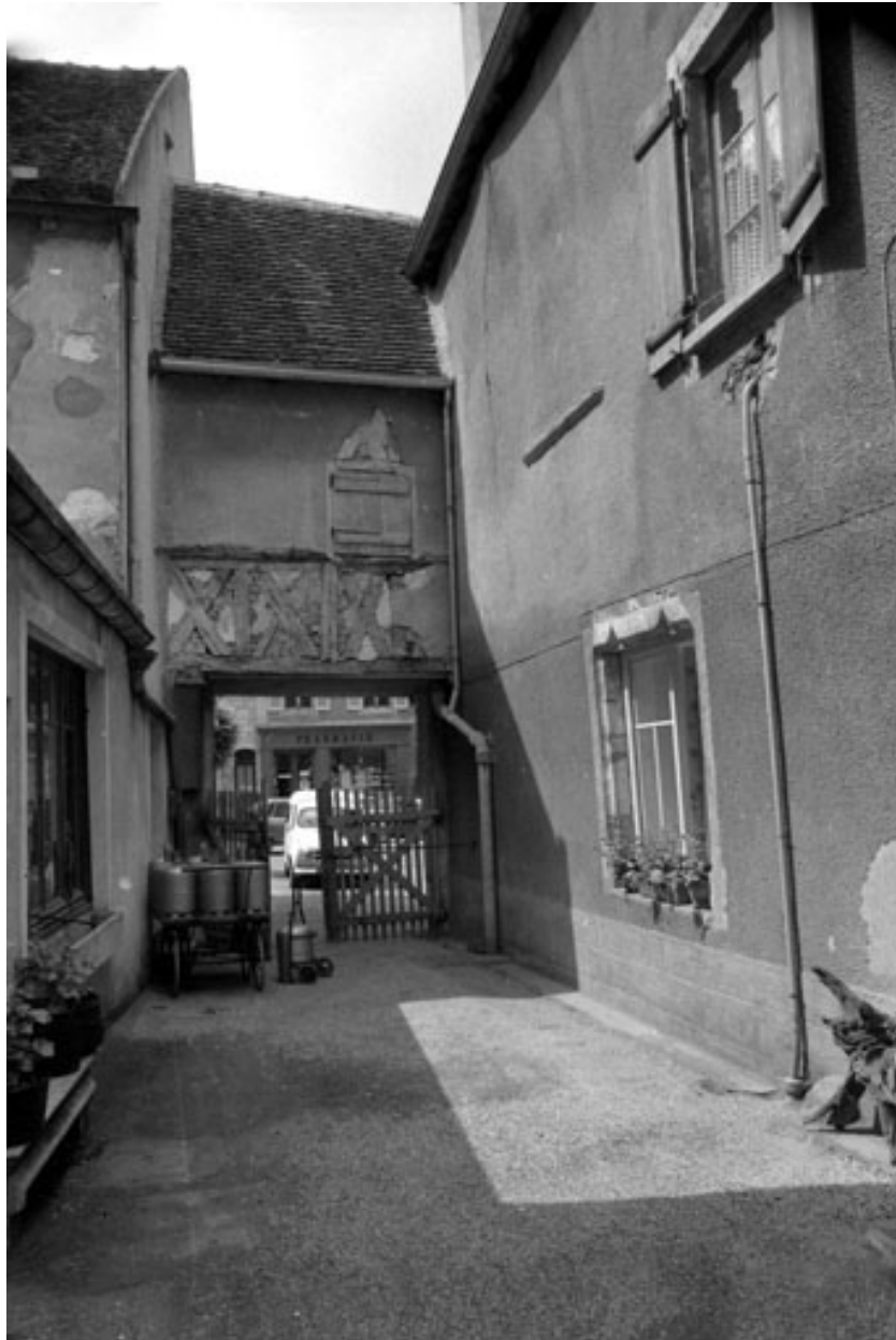
Détail passerelle couverte au-dessus de l'impasse.
