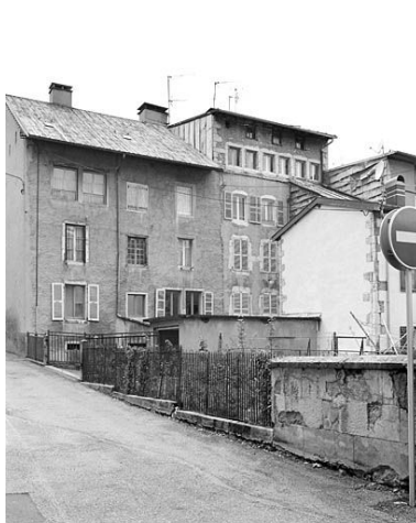
Elévation postérieure. Phot. Yves Sancey IVR43_20033900468X
