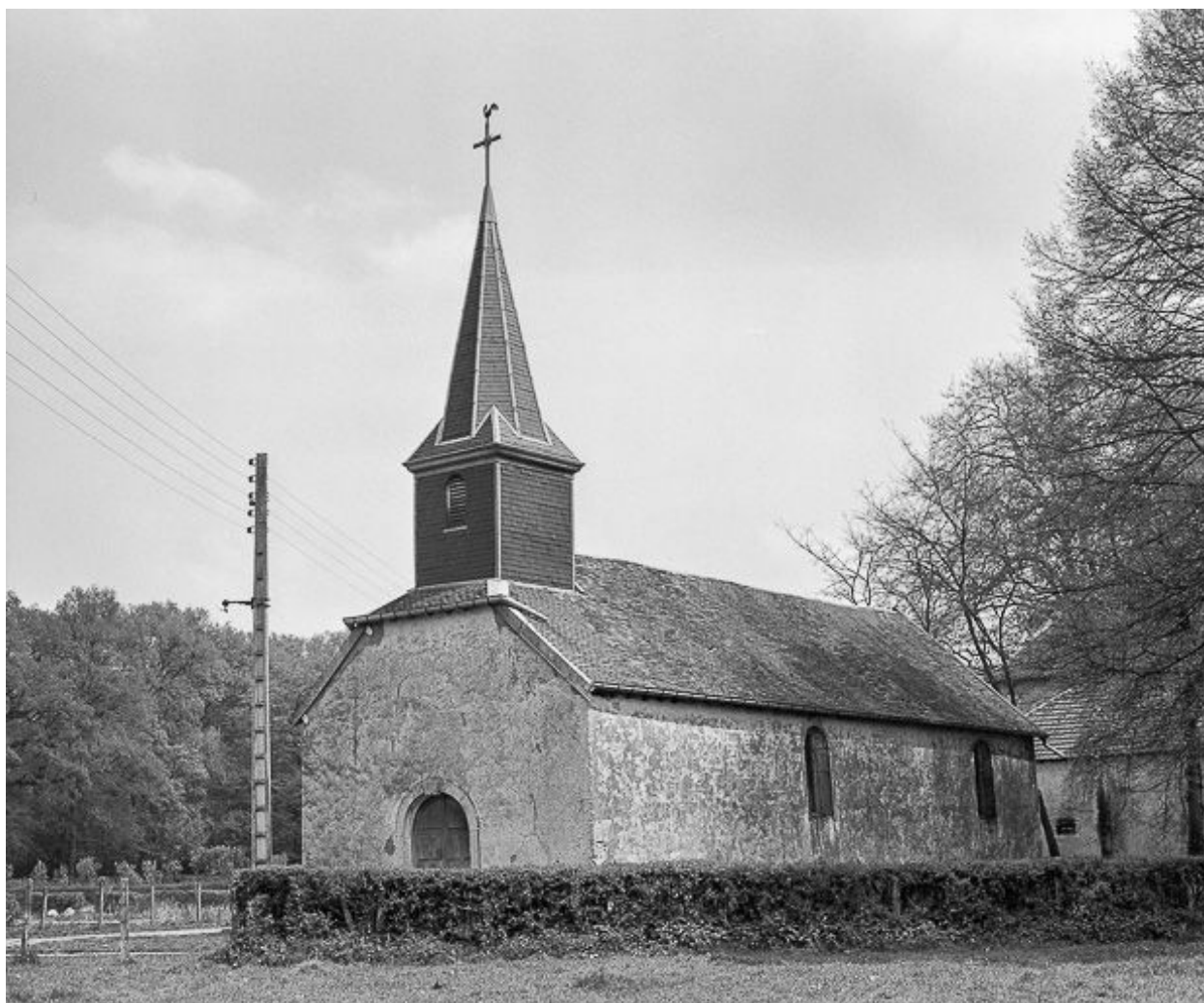
Façades antérieure et latérale droite.
