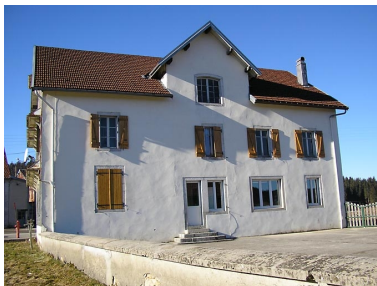
Façade postérieure. Phot. Marie-Pierre Reynet IVR43_20083900472NUC1A
