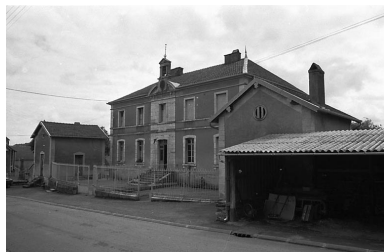
Vue d'ensemble. Phot. Yves Sancey IVR43_19817000569Z
