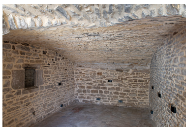
Le cellier du rez-de- chaussée, en direction du sud. Phot. Nicolas Waltefaugle IVR26_20258900290NUC4A
