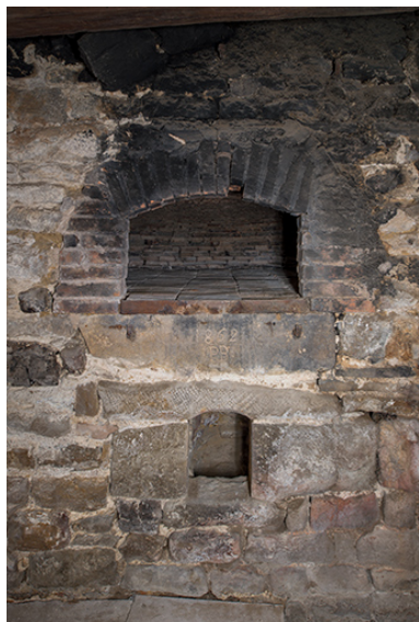
Le four à pain, détail. Phot. Nicolas Waltefaugle IVR26_20258900289NUC4A
