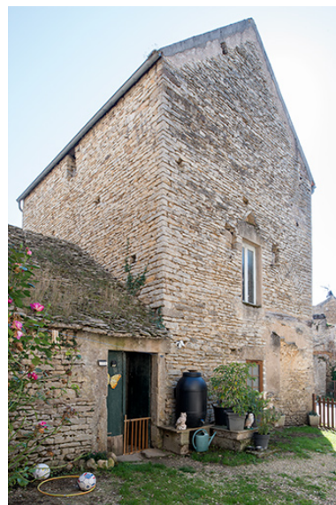
La maison depuis la cour, de trois quarts. Phot. Nicolas Waltefaugle IVR26_20258900296NUC4A
