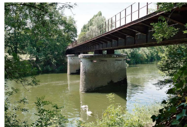
Pont de chemin de fer désaffecté.
