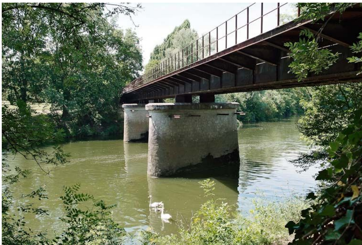
Pont de chemin de fer désaffecté.
