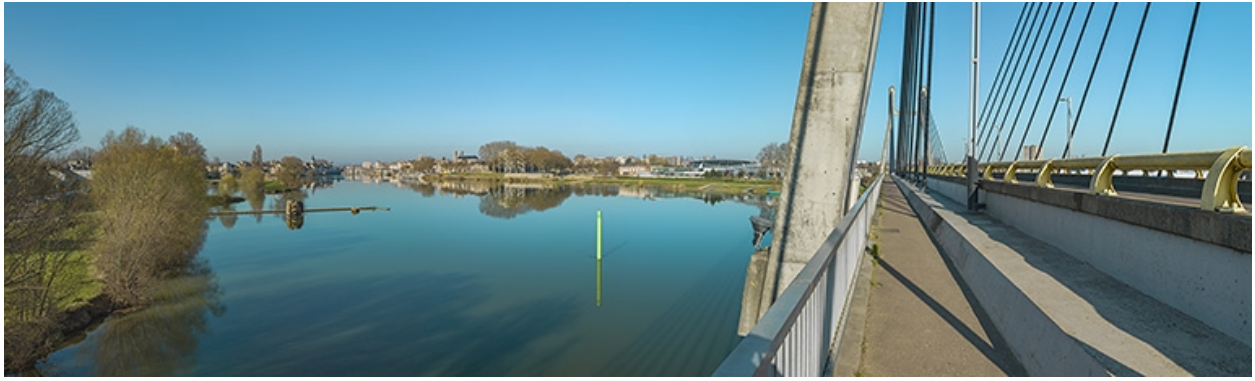
La ville de Chalon-sur-Saône vue depuis le pont de Bourgogne.
