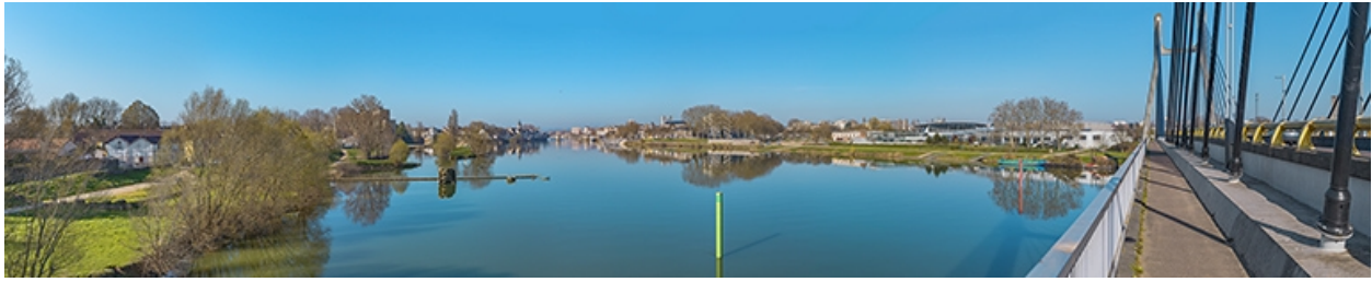
La ville de Chalon-sur-Saône vue depuis le pont de Bourgogne.
