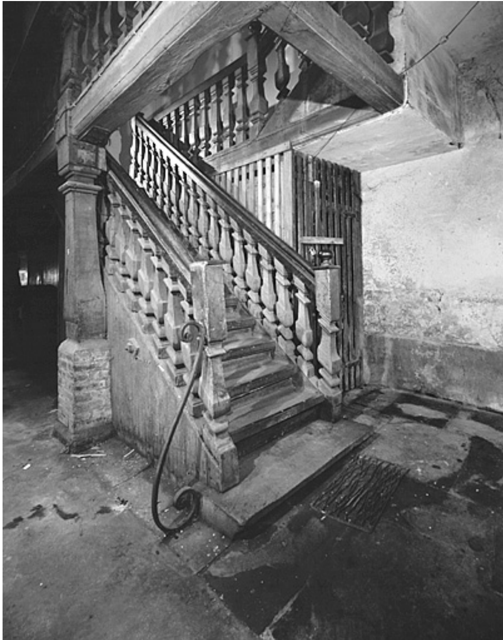
Escalier, première volée.
