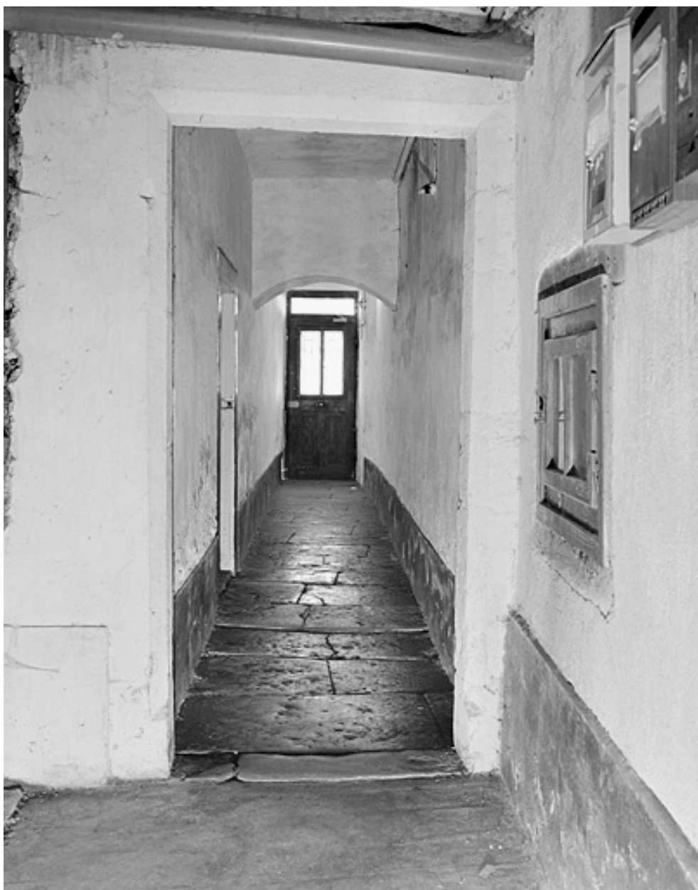
Allée du premier corps de bâtiment.
