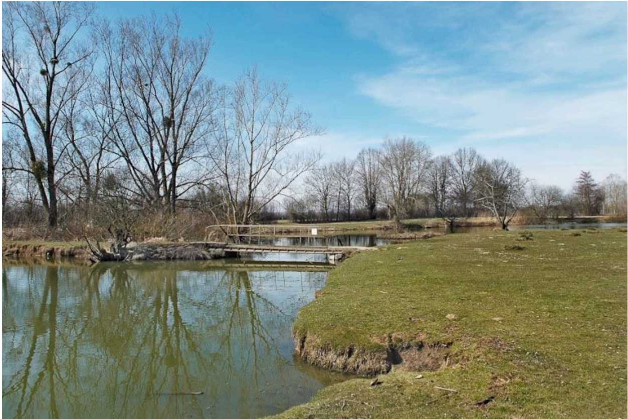
Passerelle sur une boucle de la Seille, rive gauche, à la Grande Seugnière.
