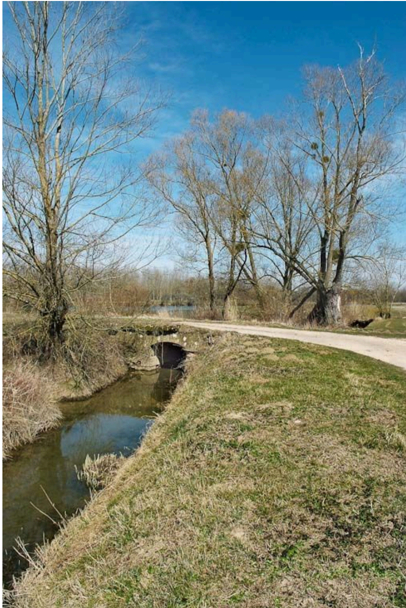
Ponceau sur une boucle de la Seille, rive gauche, à la Grande Seugnière.
