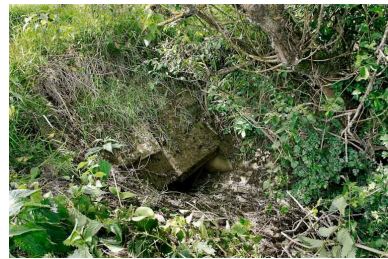
Un reste de ponceau ou d'aqueduc à Sornay. Phot. Jean-Luc Duthu IVR26_20107100320NUC2A
